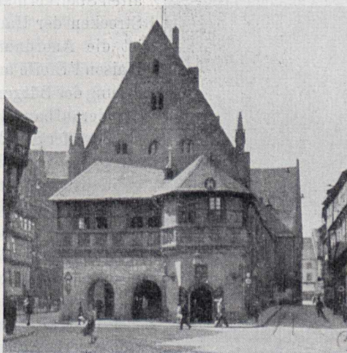
Abb. 12. Halberstadt: Rathaus, seitlicher Durchbruch zur Verkehrserleichterung, Ansicht.
