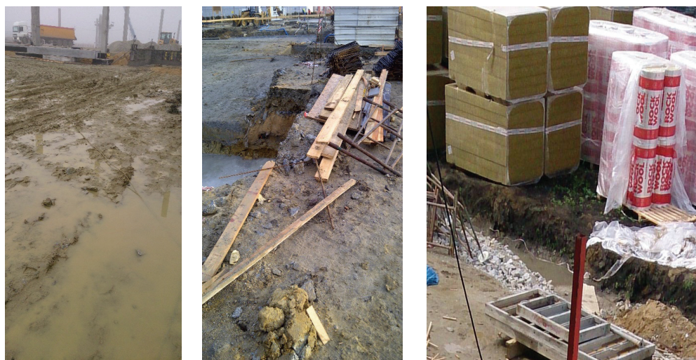
Rys. 6.17. Przykładowe warunki na terenie budowy [fot. M. Szóstak]
