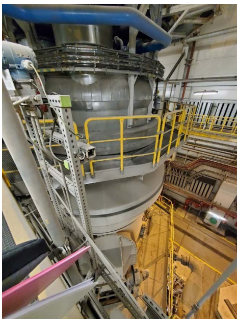
Rys. 2.2. Młyn węglowy – widok: a) z lewej, b) od dołu, c) z prawej, d) od góry
