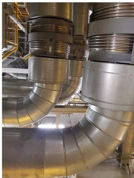
Rys. 2.38. Kompensatory przed palnikiem – widok: a) z boku, b) od dołu
