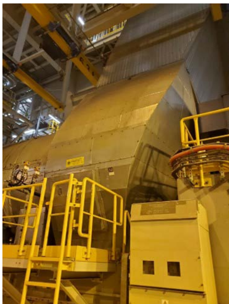
Rys. 2.34. Wentylator podmuchowy powietrza: a) widok z przodu, b) widok z boku, c) porównanie wielkości wentylatora i przewodu ssawnego ze wzrostem człowieka
