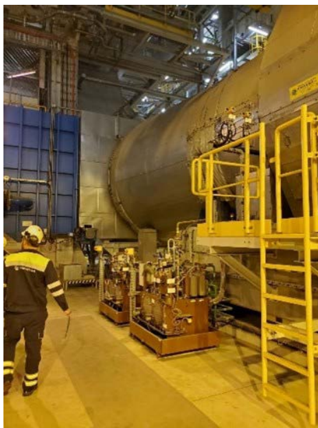
Rys. 2.34. Wentylator podmuchowy powietrza: a) widok z przodu, b) widok z boku, c) porównanie wielkości wentylatora i przewodu ssawnego ze wzrostem człowieka
