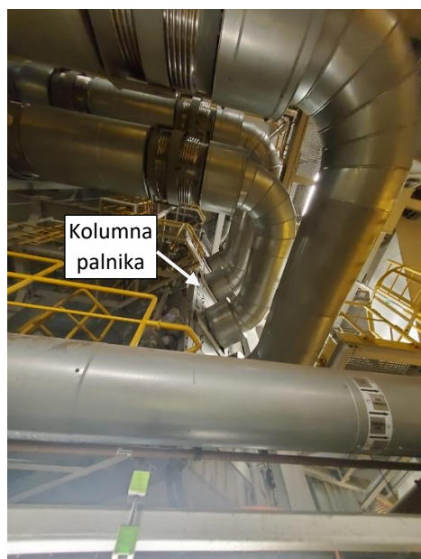
Rys. 2.38. Kompensatory przed palnikiem – widok: a) z boku, b) od dołu
