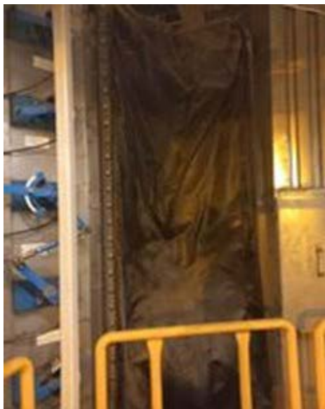
Rys. 3.35. Kompensator przy palniku jako konsekwencja rozkładu ciśnienia w pasie palnikowym: a) wybrzuszony, b) wklęsnięty
