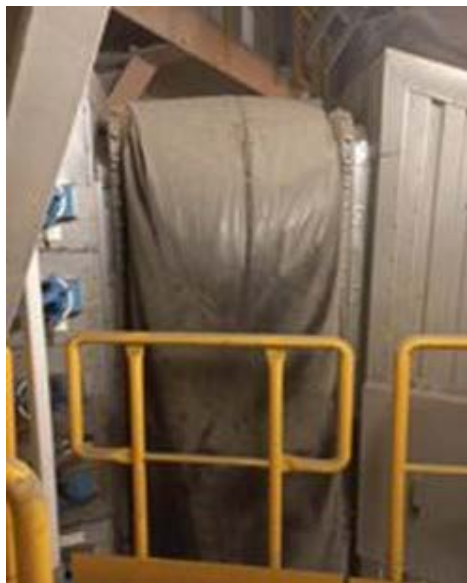
Rys. 3.35. Kompensator przy palniku jako konsekwencja rozkładu ciśnienia w pasie palnikowym: a) wybrzuszony, b) wklęsnięty
