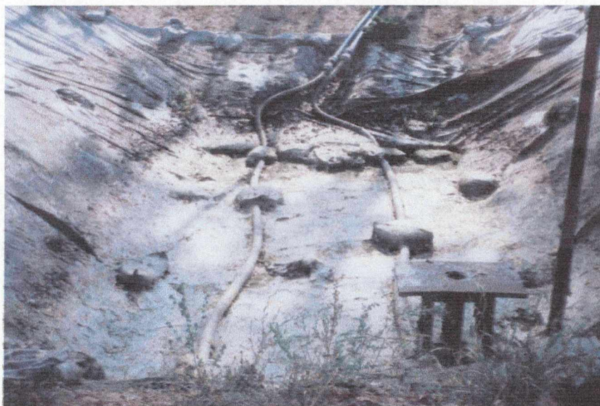
Rys. 43. Widok basenu infiltracyjnego po zakończeniu 2 serii badań
