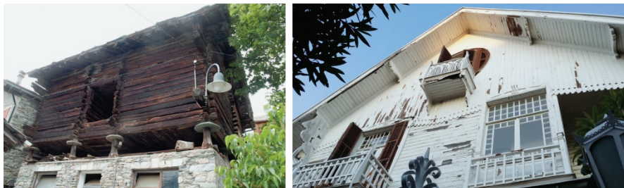
Rys. 3.10. Tradycyjne domy drewniane 92 : wiejski budynek gospodarczy w miejscowości Antagnod, Val d' Ayas, Włochy (po lewej); dom mieszkalny na wyspie Büyükada, w archipelagu Wysp Książęcych na Morzu Marmara, Turcja (po prawej)
