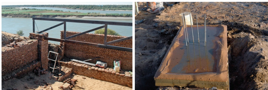
Rys. 3.7. Stara Dongola w północnym Sudanie – przykłady prac budowlanych: obiekt B.V. – lekka konstrukcja dachu ze stalowych kratownic (po lewej) i zabezpieczenie właściwych warunków dojrzewania betonu w stopie fundamentowej poprzez nałożenie grubej warstwy mokrego piasku (po prawej) 89
