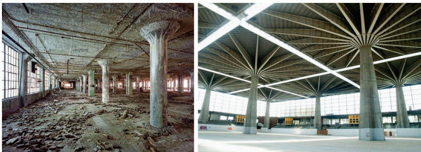
Rys. 3.14. Ruiny w znaczeniu technicznym – budynek przemysłowy w Detroit, USA (po lewej) 97 oraz ruiny w znaczeniu społecznym – Palazzo del Lavoro, Turyn, Włochy 98
