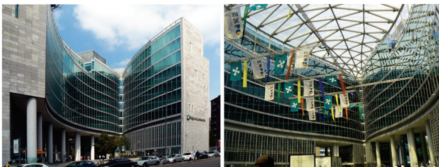
Rys. 3.1. Palazzo Lombardia – budynek władz regionalnych Lombardii w Mediolanie (proj. Pei Cobb Freed & Partners) widok z zewnątrz (po lewej) i transparentne zadaszenie dziedzińca wewnętrznego 75 w tym budynku (po prawej)
