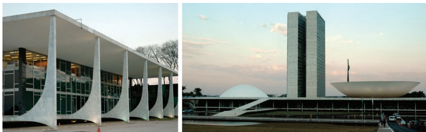
Rys. 3.4. Budynki rządowe na Placu Trzech Władz (Praça dos Três Poderes) w Brasílii (proj. Oscar Niemeyer i Lúcio Costa): Federalny Sąd Najwyższy (po lewej) i Kongres Narodowy (po prawej) 79
