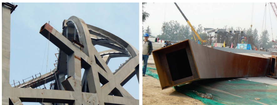
Rys. 3.6. Elementy konstrukcji stalowej stadionu olimpijskiego w Pekinie, na placu budowy 83
