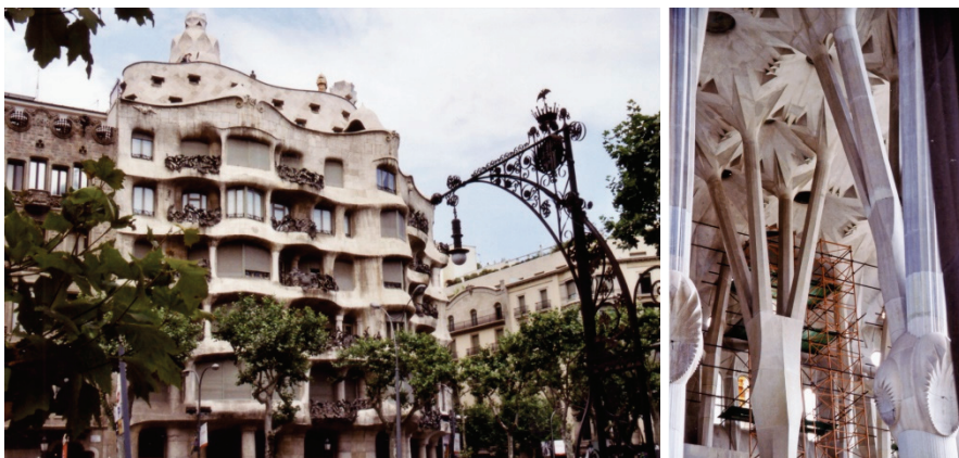
Rys. 2.12. Dwa budynki proj. A. Gaudiego w Barcelonie: Casa Milà (1905–1907) i Sagrada Família (1882–...) 41
