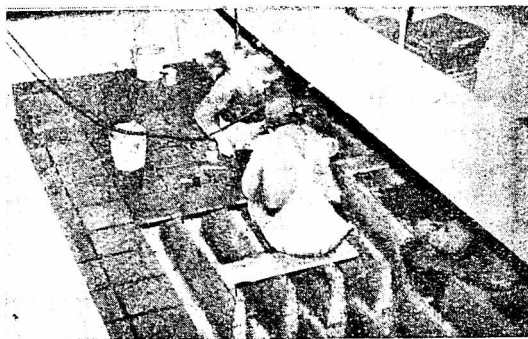
Rys. 7 — Montaż filtru z płyt porowatych.
