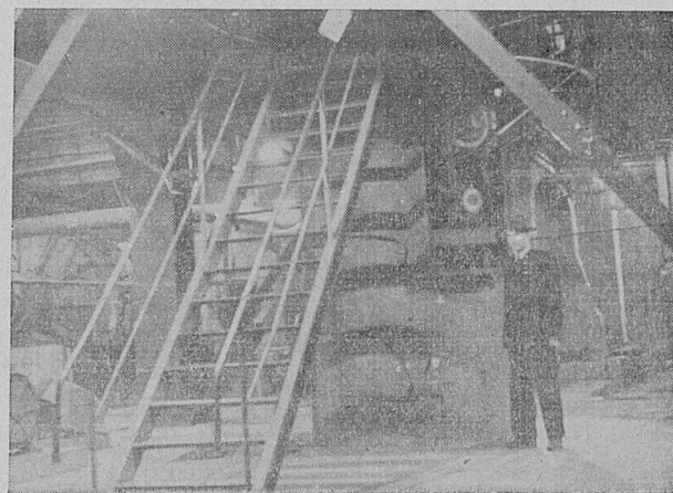
Rys. 17. Koronka spustowa w stanie wykończonym.
