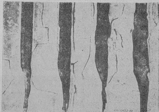
Rys. 8. Ekran paleniska pokryty warstwą żużla.
