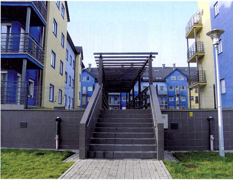
Il. 3.78. Wrocław, ul. Strońska. Otwarta brama prowadząca do wnętrza zespołu zabudowy (fot. B. G.)
