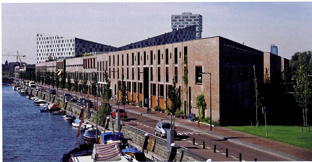
Il. 3.70. Amsterdam, zabudowa półwyspu Sporenburg. Zwarta zabudowa, zgrabnie połączonych szeregów powtarzalnych domów, złamana została dużymi blokami mieszkalnymi, stanowiącymi kontrast z niską zabudową. Poprzecznie zorientowano tereny zielone. W tle widoczny budynek The Whale, przypominający wieloryba, z wybujałą formą i cynkowymi fasadami (fot. B. G.)
