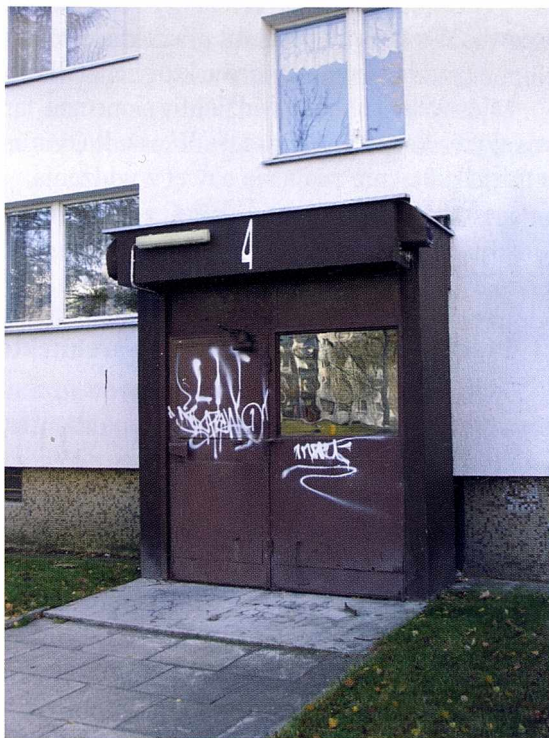
Il. 4.40. Osiedle Jana III Sobieskiego, ul. Hetmańska 4. Rozwiązanie strefy wejściowej, widok drzwi wejściowych (fot. B. G.)
