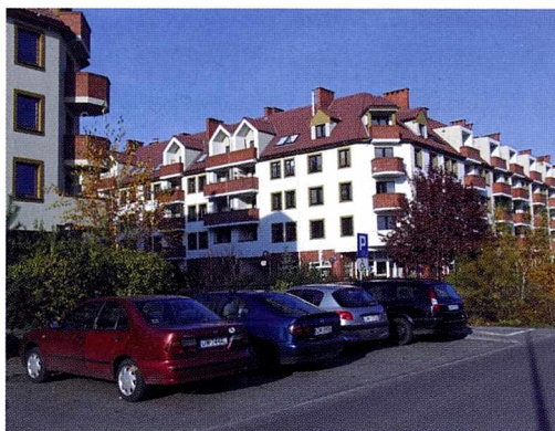
Il. 3.47. Wrocław, ul Jaracza. Miejsca parkingowe oddzielone od budynków pasem zieleni, rozwiązane wzdłuż ulic dojazdowych, z wydzielonymi miejscami dla osób niepełnosprawnych (fot. B. G.)
