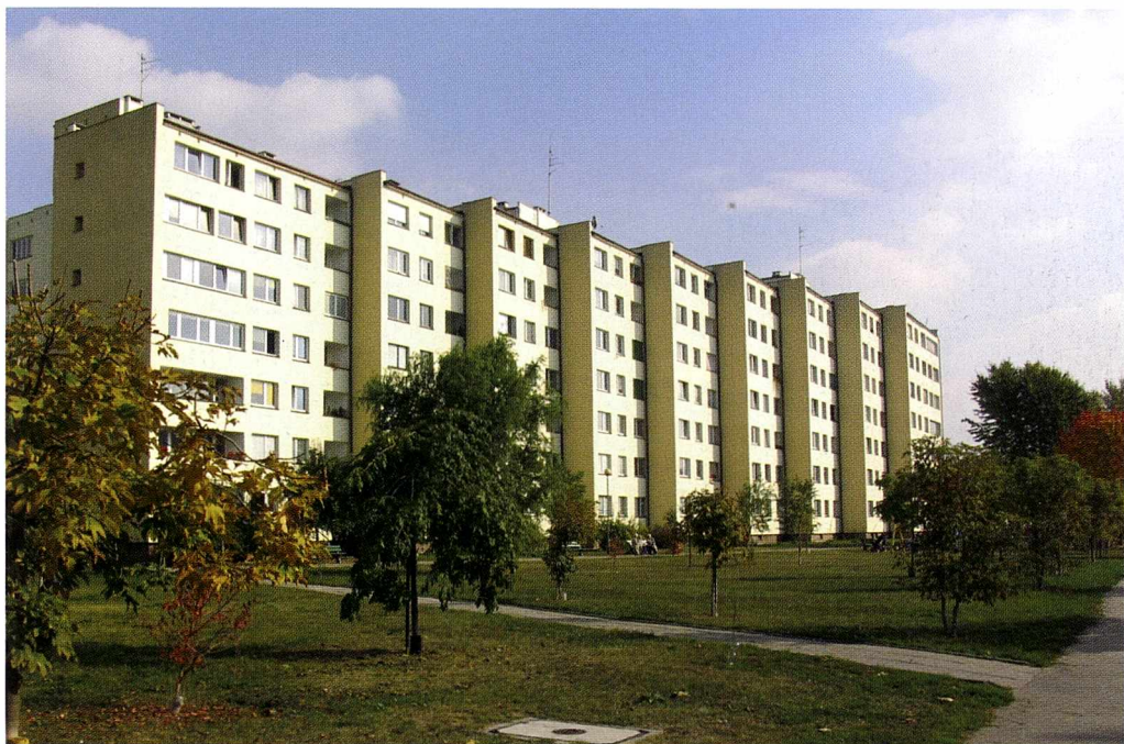
Il. 4.17. Osiedle Bartoszowice, ul. Bacciarellego 2, 2a. Widok osiedla od strony ulicy Bacciarellego, na pierwszym planie budynek korytarzowy (fot. B. G.)
