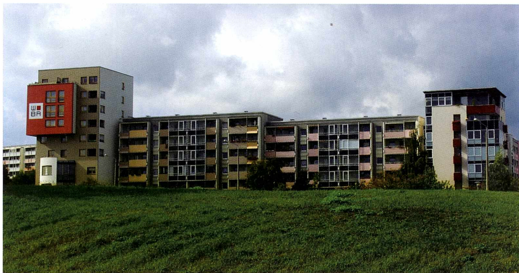
Il. 3.105. Drezno, dzielnica Görbitz. Fragment zmodernizowanej zabudowy z wielkiej płyty, po wprowadzeniu nowej zabudowy w narożnikach starej tkanki (fot. B. G.)
