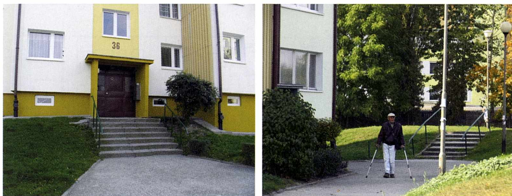
Il. 4.21. Osiedle Bartoszowice, ul. Bacciarellego 36. Wejścia do budynków oraz schody na terenach rekreacyjnych nieprzystosowane dla osób niepełnosprawnych (fot. B. G.)
