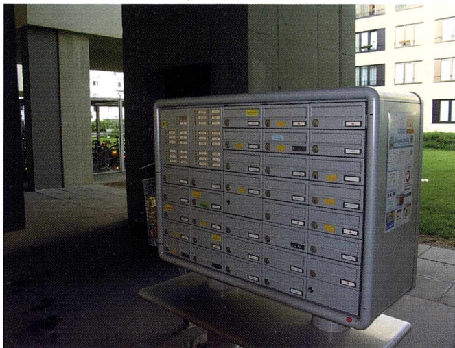
Il. 3.55. Wiedeń, osiedle Duckendasse. Skrzynka na listy umieszczona na zewnątrz klatki schodowej eliminuje konieczność wejścia na klatkę schodową (fot. B. G.)
