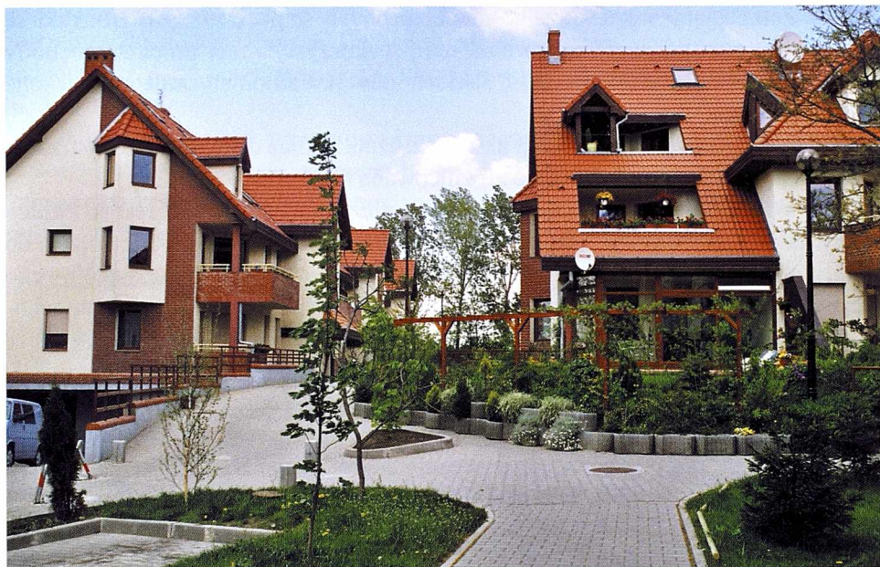
II. 3.31. Wrocław-Wysoka, ul. Chabrowa. Nieformalny układ rozwiązania ulic, nie ma wydzielonych miejsc dla pieszych, ale ulica umożliwia również ruch samochodów (fot. B. G.)
