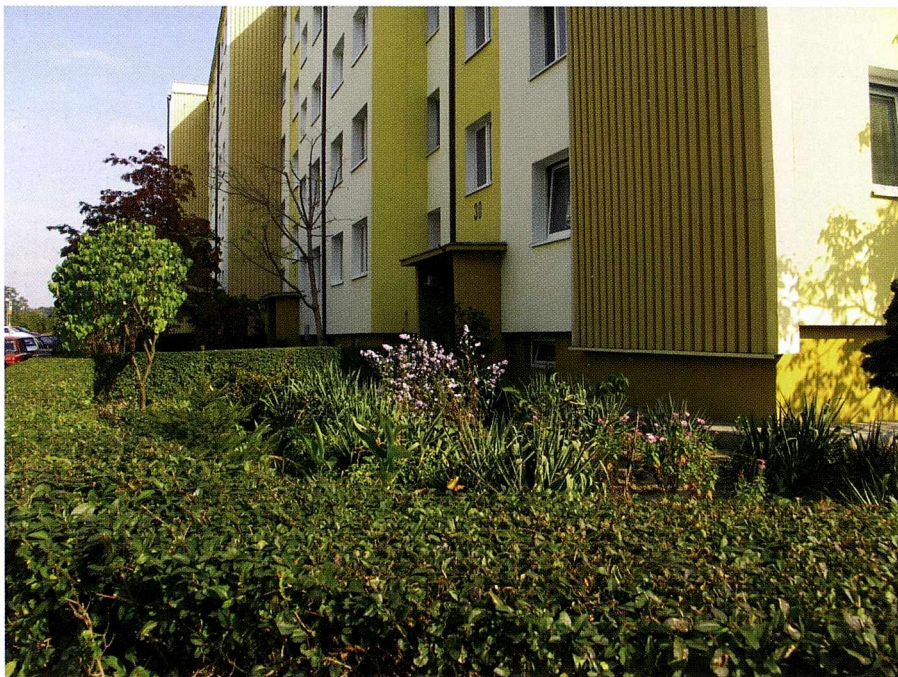
Il. 4.20. Osiedle Bartoszowice, ul. Canaletta 48 i 50. Indywidualne inicjatywy zawłaszczania terenu na ogródki przydomowe (fot. B. G.)
