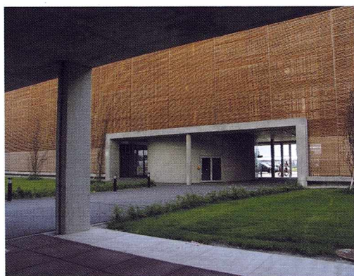
Il. 3.44. Wiedeń, osiedle Duckengasse. Parking wielopoziomowy z elewacją wykonaną z drobnych desek, widok z wnętrza blokowego (fot. B. G.)
