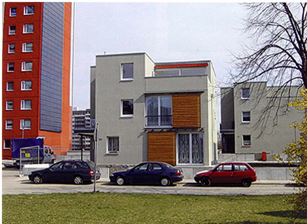
Il. 3.108. Cottbus, osiedle Sachsendorf-Madlow. Widok nowej zabudowy z materiałów uzyskanych z wyburzenia (fot. B. G.)
