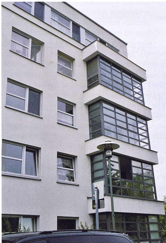
Il. 3.61. Berlin, osiedle Aalemannufer. Elewacja z przeszklonymi zielonymi izbami (fot. B. G.)
