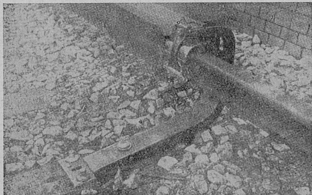
Rys. 5. Zamocowanie trzeciej szyny w S-Bahn w Berlinie (rozwiązanie typowe)
