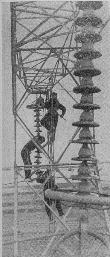
Montaż izolacji i przewodów linii 220-kilowoltowej
