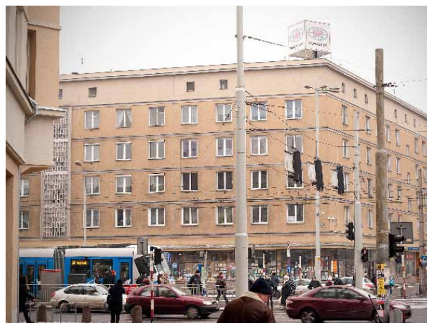
Fot. 22. Zabudowa narożna z lat 60. XX w. ulic Piłsudskiego i Grabiszyńskiej we Wrocławiu, fot. L.S. Konarzewski-Plewa
