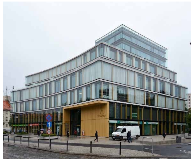
Fot. 51. Budynek usługowo-mieszkalny Thespian przy placu Powstańców Śląskich we Wrocławiu – widok od strony placu na główne wejście, fot. L.S. Konarzewski-Plewa
