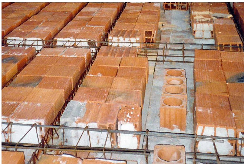
Fot. 58. Przykład stropu gęstożebrowego ceramicznego w trakcie montażu (strop Ceram), fot. R. Tarczewski
