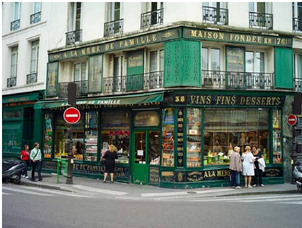
Fot. 5. Historyczny lokal handlowy w parterze kamienicy przy Rue du Faubourg-Montmartre w Paryżu (sklep À la Mère de Famille) z mieszkaniami na wyższych kondygnacjach; przykład śródmiejskiej zabudowy mixed-use , kontynuującej tradycję usług w parterze i lokali mieszkalnych powyżej, fot. Alexandre Vialle, Wikimedia Commons, licencja CC BY 2.0
