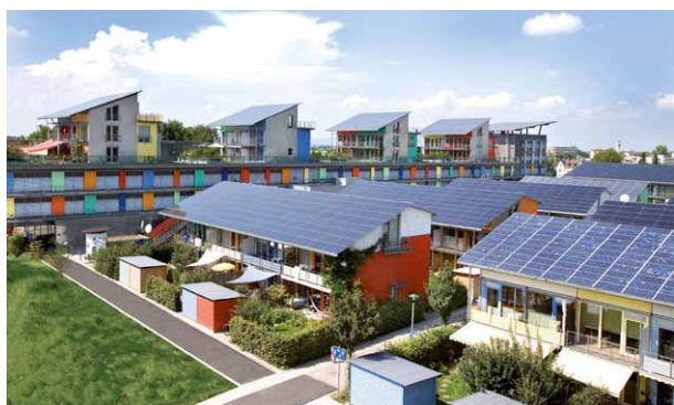
Fot. 13. Solarsiedlung am Schlierberg i „Sonnenschiff” w dzielnicy Vauban we Fryburgu Bryzgowijskim (proj. Rolf Disch Solar Architecture, realizacja: 1999–2006) – plusenergetyczne osiedle mieszkaniowo-usługowe z dachami fotowoltaicznymi i lokalnymi usługami w parterach; przykład zrównoważonego mixed-use w skali zespołu. Źródło: Andrewglaser, Wikimedia Commons, licencja CC BY-SA 3.0
