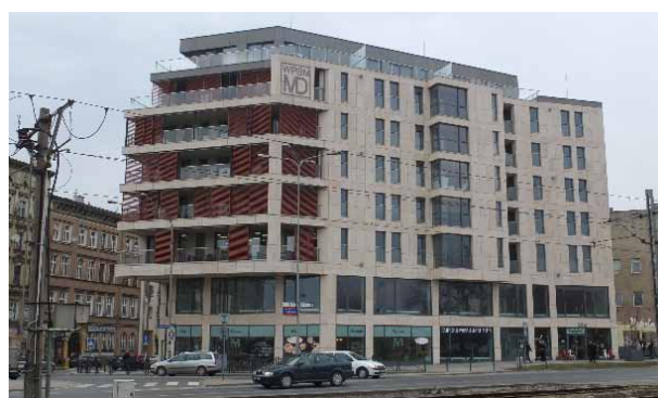
Fot. 30. Budynek usługowo-mieszkalny z początku XXI w. na rogu ulic Drobnera i Jedności Narodowej we Wrocławiu, fot. L.S. Konarzewski-Plewa (przykład 34)
