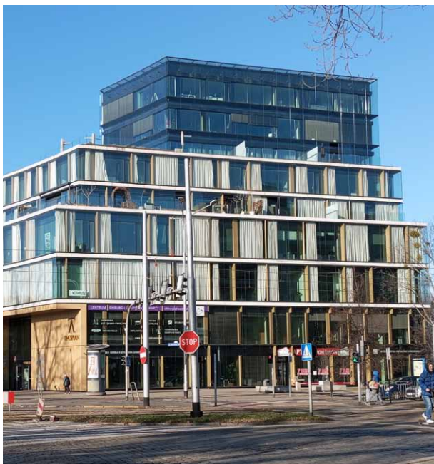
Fot. 31. Budynek wielofunkcyjny Thespian przy placu Powstańców Śląskich we Wrocławiu, fot. L.S. Konarzewski-Plewa (przykład 33)
