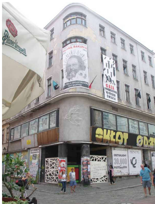
Fot. 20. Kamienica z lat 20–30 XX w. narożna na Starym Rynku w Poznaniu – widok od strony Rynku, fot. L.S. Konarzewski-Plewa
