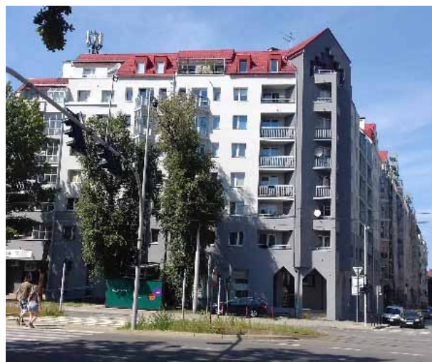
Fot. 26. Budynek z lat 90. XX w. na rogu ulic Sienkiewicza i Świętokrzyskiej we Wrocławiu, fot. L.S. Konarzewski-Plewa (przykład 6)
