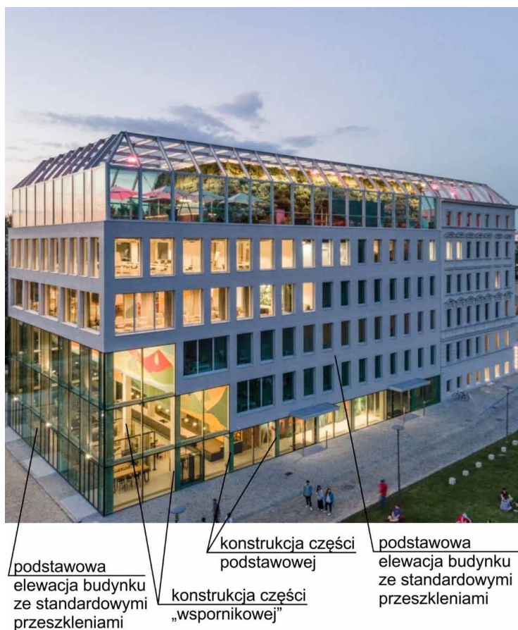
Il. 131. Concordia Design we Wrocławiu jako przykład budynku, w którym zastosowano efekt wizualny pozornego nadwieszenia wspornikowego. Opracowanie własne z wykorzystaniem fotografii autorstwa Juliusza Sokołowskiego (za zgodą autora)
