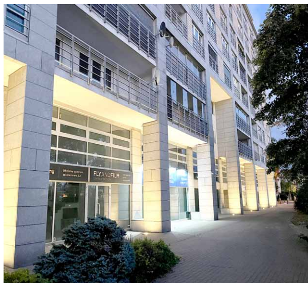
Fot. 53. Zespół Babka Tower przy ulicy Słomińskiego i alei Jana Pawła II oraz rondzie Zgrupowania AK „Radostaw” w Warszawie – widok od alei Jana Pawła II, fot. E. Komarzyńska-Świeściak
