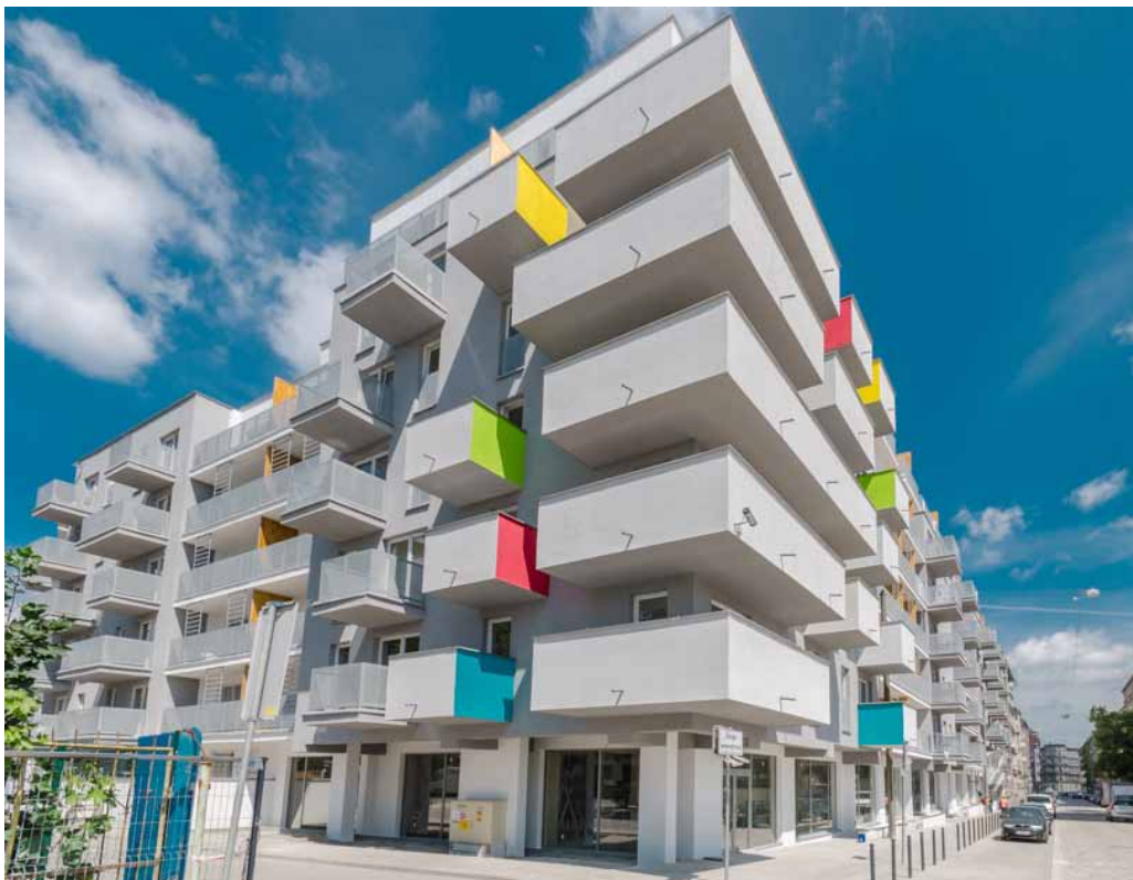
Fot. 56. Budynek usługowo-mieszkaniowy przy ulicy Prądyńskiego 47–63 we Wrocławiu – widok od narożnika (przykład 35), fot. L.S. Konarzewski-Plewa
