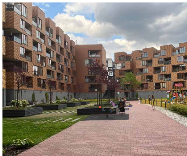
Fot. 35. Zespół mieszkaniowo-usługowy Corte-Verona we Wrocławiu między ulicami: Grabiszyńską, Inżynierską, Magazynierską oraz aleją Pracy, widok wnętrza kwartału, fot. E. Komarzyńska-Świeściak
