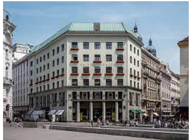
Fot. 6. Looshaus (dom towarowy Goldman & Salatsch) przy Michaelerplatz w Wiedniu (proj. Adolf Loos, realizacja: ok. 1910–1912) – modernistyczny budynek usługowo-mieszkaniowy z lokalami handlowo-biurowymi w parterze oraz mieszkaniami na wyższych kondygnacjach; przykład wyraźnej pionowej segregacji funkcji, rozwijającej XIX-wieczny model kamienicy z usługami w parterze i mieszkaniami powyżej, fot. Thomas Ledl, Wikimedia Commons, licencja CC BY-SA 4.0
