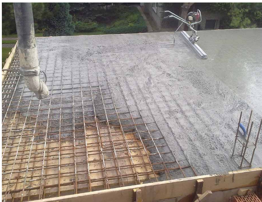
Fot. 61. Przykład stropu żelbetowego monolitycznego w trakcie realizacji. Źródło: https://www.cabanbruk.pl/galeria-budowy-remonty-wykonczenia/#lg=1&slide=6 (dzięki uprzejmości firmy PHU CABANBRUK Grzegorz Caban, Wilcza), fot. autor nieznany
