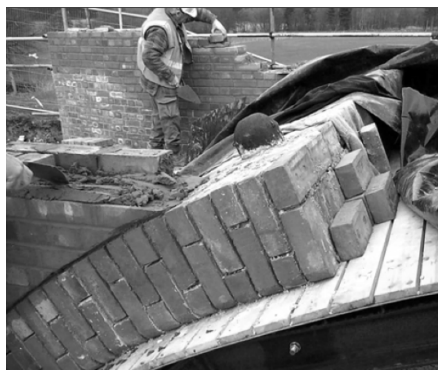
Rys. 3.14. Połączenie ścian bocznych ze sklepieniem gładką warstwą zaprawy [N27] (a) i zębami klinów (b)
