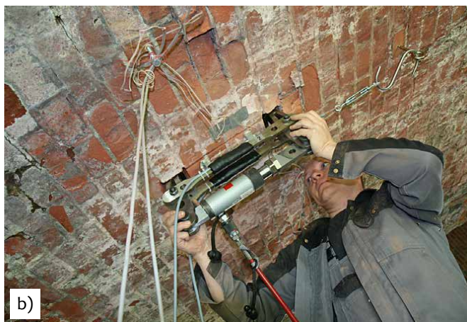
Rys. 4.15. Siłownik hydrauliczny: a) schemat narzędzia [136], b) zastosowanie na sklepieniu ceglanym [215]
