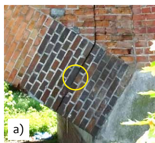
Rys. 3.4. Sposoby wymuszenia przebiegu linii ciśnień w sklepieniu: a) zastosowanie przegubu konstrukcyjnego (fot. BPK Mosty), b) zastosowanie sekwencji murowania sklepienia [W9]
