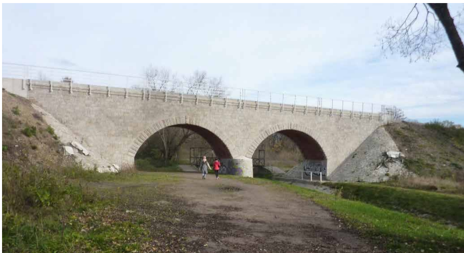
Rys. 5.33. Most nad rzeką Witoszówką w Świdnicy (widok po remoncie)
