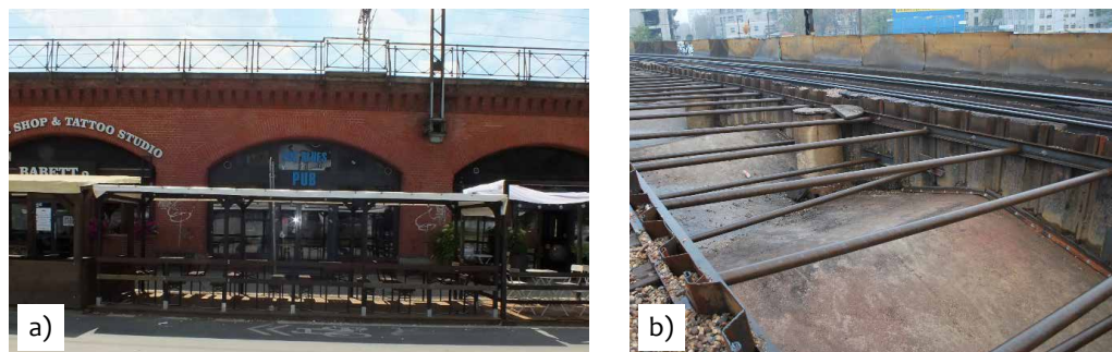
Rys. 7.14. Estakada kolejowa E4: a) widok z boku, b) widok z góry podczas remontu
