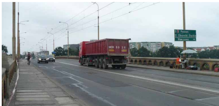
Rys. 5.14. Pojazdy przejeżdżające przez obiekt w trakcie pomiaru nr 4
