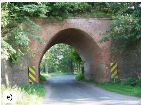
Rys. 3.11. Kształty profilu sklepień MMS: a) półkolisty, b), c) odcinkowy, d) ostrołukowy, e) paraboliczny, f) eliptyczny
