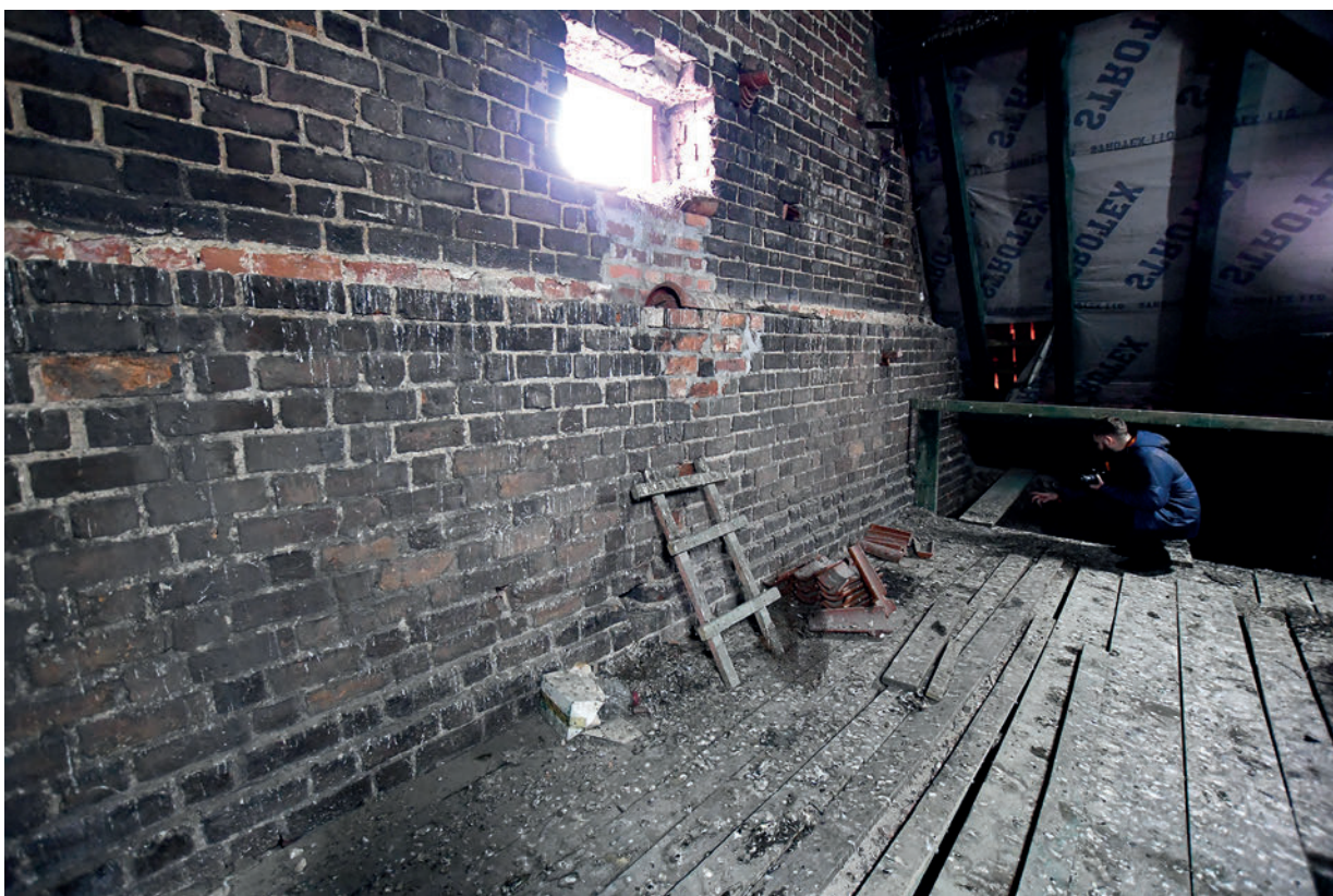
Il. 154. 2022 r. Strychy – ściana zachodnia; fot. A.H.
