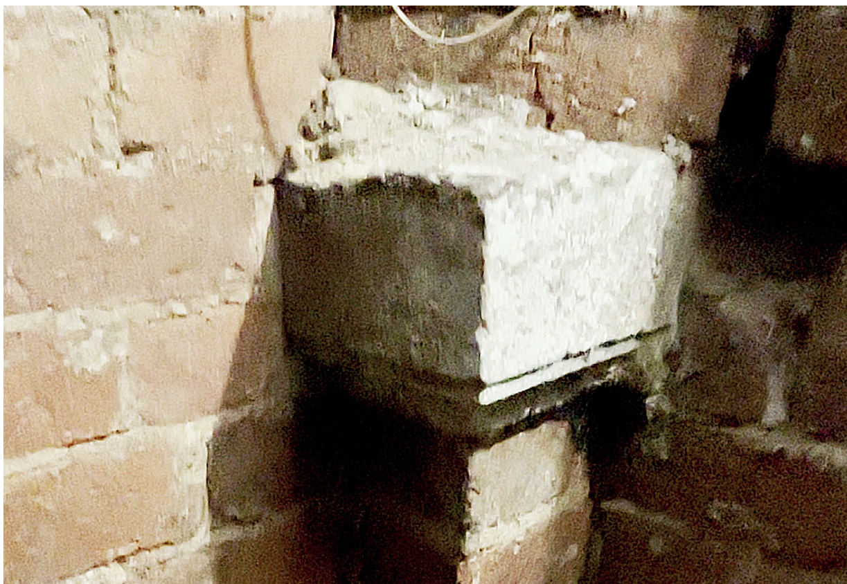
Il. 132. 2023 r. Krypta pod prezbiterium – zachowana głowica pilastra; fot. A.H.
