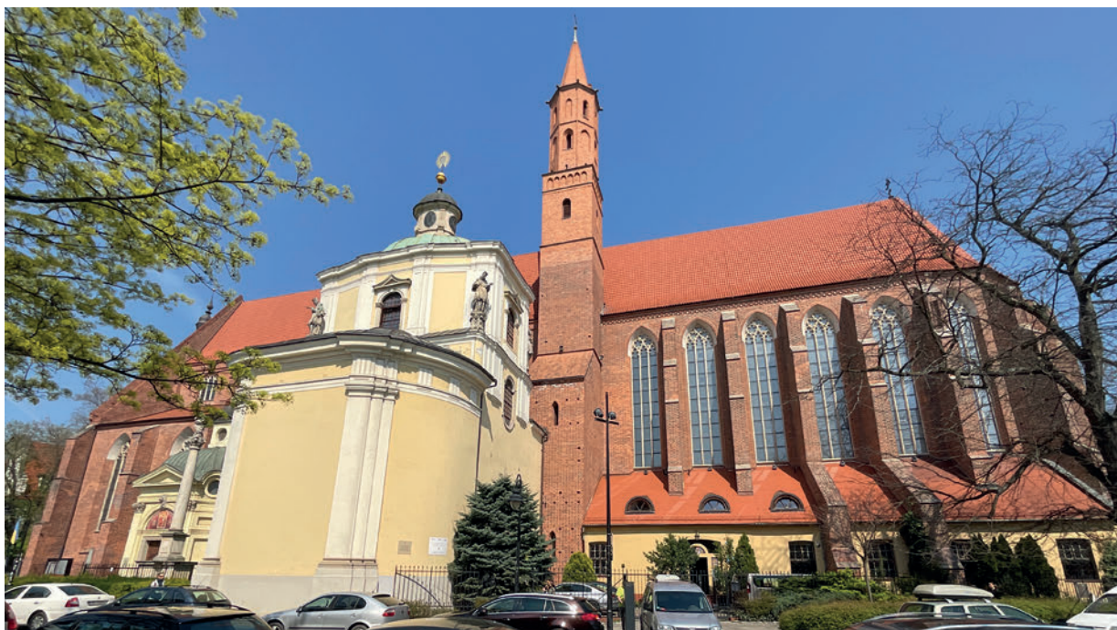
Il. 123. 2023 r. Elewacja południowa; fot. A.H.
