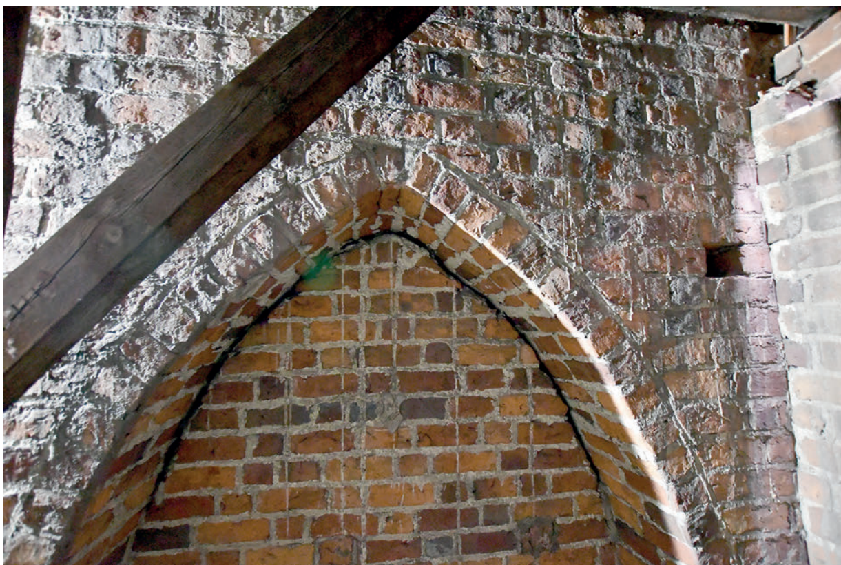
II. 157. 2022 r. Strychy – łuk konstrukcyjny nad ścianą arkadową; fot. A.H.
