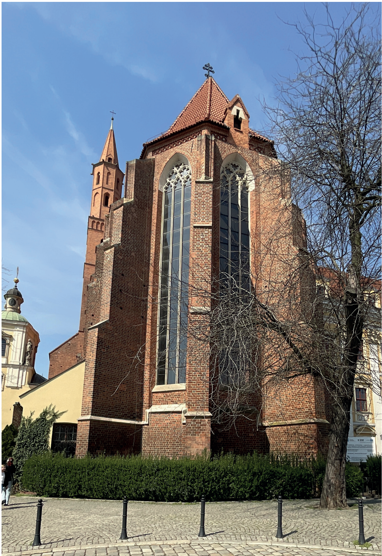
Il. 122. 2023 r. Elewacja wschodnia; fot. A.H.
