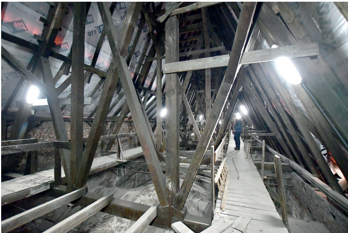
Il. 153. 2022 r. Strychy – więźba dachowa; fot. A.H.
