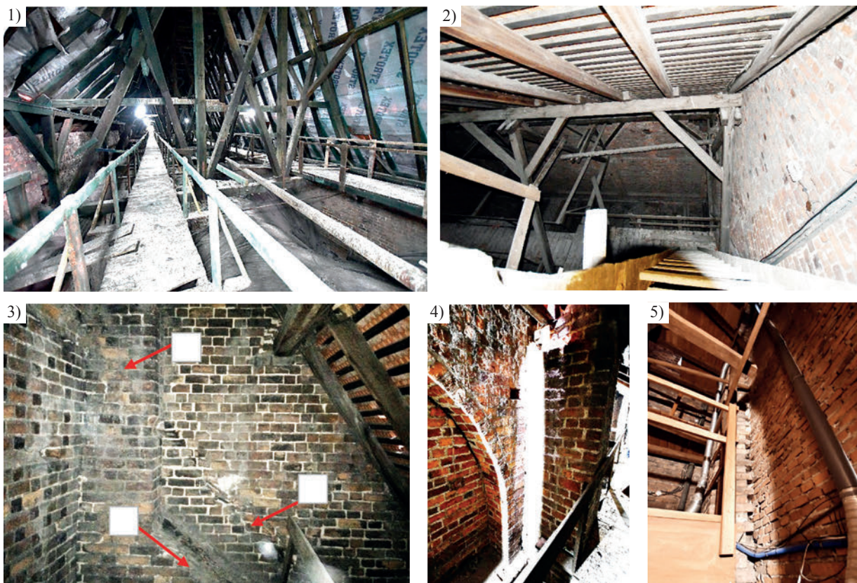
II. 24. Strychy: 1) więźba dachowa nad prezbiterium, 2) więźba dachowa nad nawą północną i dawnym krużgankiem klasztoru, 3) ściana zachodnia nawy północnej: A – przypora(?), B – dawny poziom oparcia dachu, 4) ostrołuczne nisze konstrukcyjne w ścianie arkadowej nawy głównej, 5) wnętrze wieży (stan z 2021); oprac. A.H.
