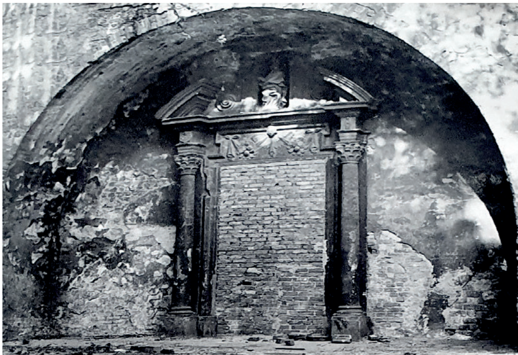
Il. 105. Okolo 1958 r. Wstępnie zabezpieczone okno nawy bocznej elewacji zachodniej oraz zabezpieczenie portalu zachodniego; zbiory NID Wrocław, [za:] (Eysymontt 1965a, il. 52, il. 53)
