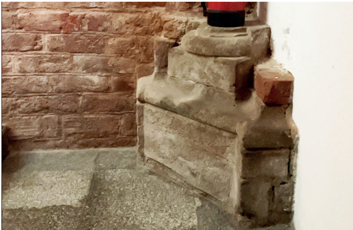
Il. 134. 2023 r. Zejście do krypty zachodniej – zachowana baza pilastra; fot. A.H.
