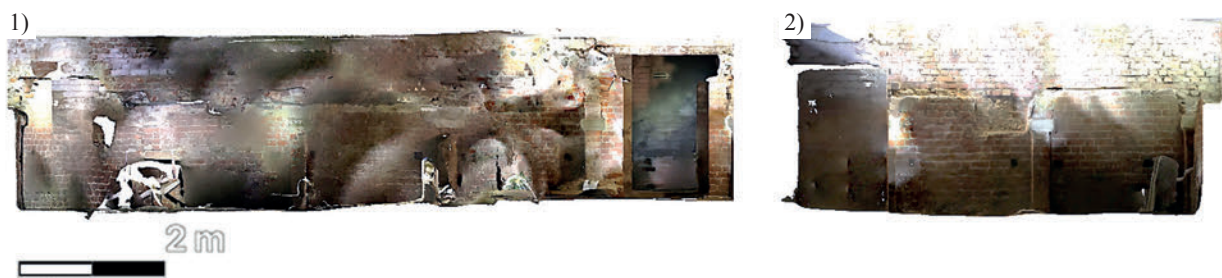
Il. 23. Krypta pod prezbiterium, fotomapa: 1) elewacja południowa, 2) elewacja zachodnia (stan z 2022); oprac. A.H.
