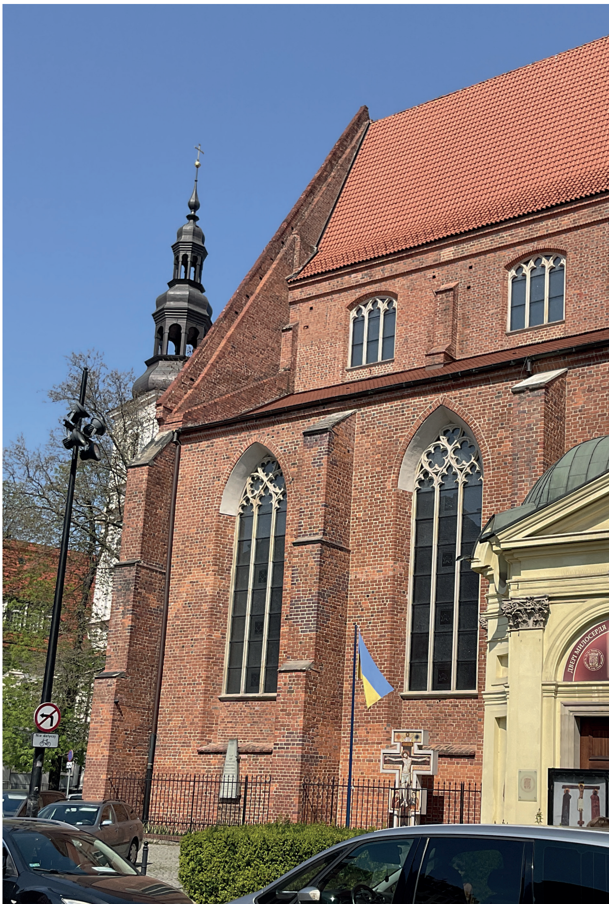
Il. 127. 2023 r. Ściana szczytowa elewacji zachodniej – widok od południa; fot. A.H.
