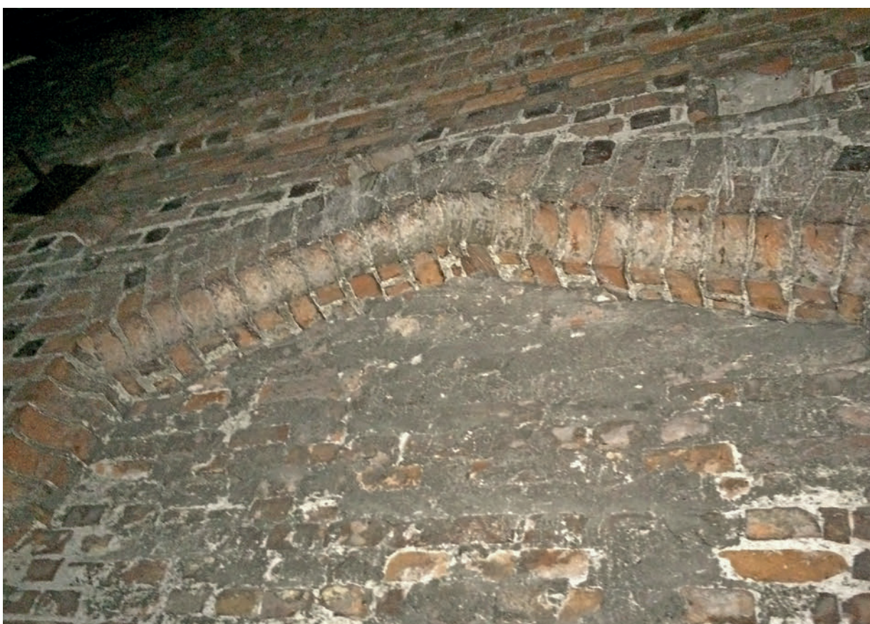
II. 158. 2022 r. Strychy – blokada okna nawy głównej od strony północnej; fot. A.H.
