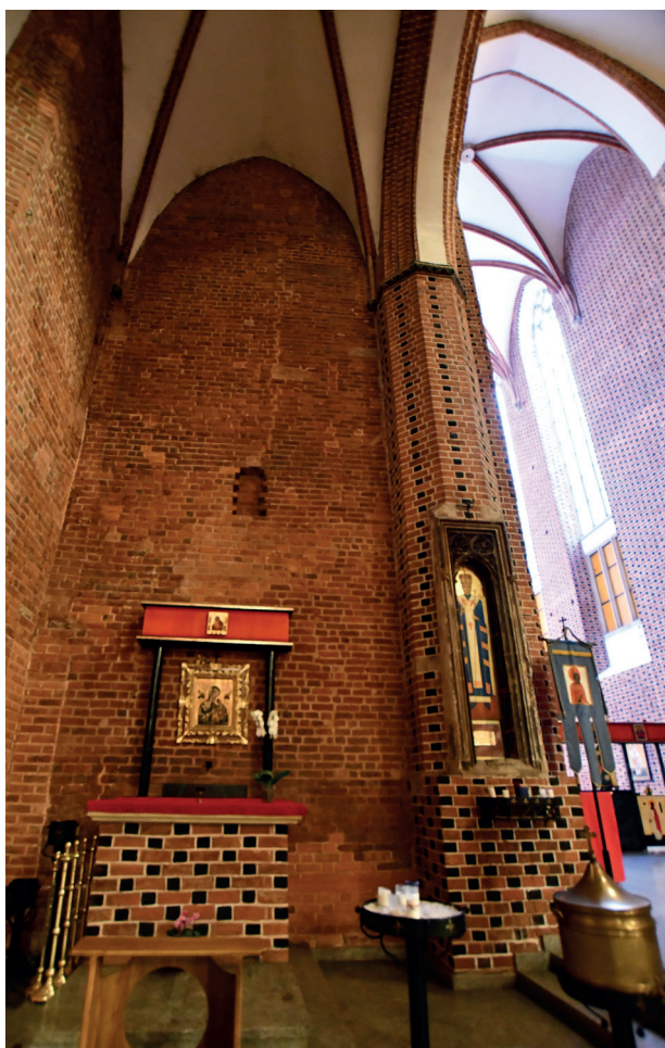
Il. 147. 2023 r. Przyziemie – nawa północna (ściana wschodnia); fot. A.H.
