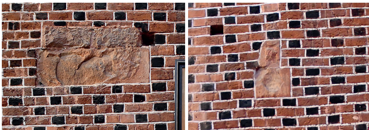
Il. 138. 2023 r. Przyzemie – prezbiterium (relikty wsporników sklepiennych); fot. A.H.
