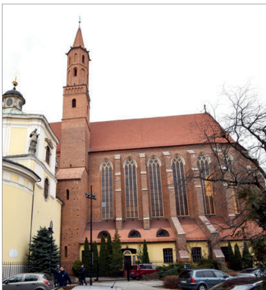
Il. 124. 2023 r. Elewacja południowa – prezbiterium; fot. A.H.
