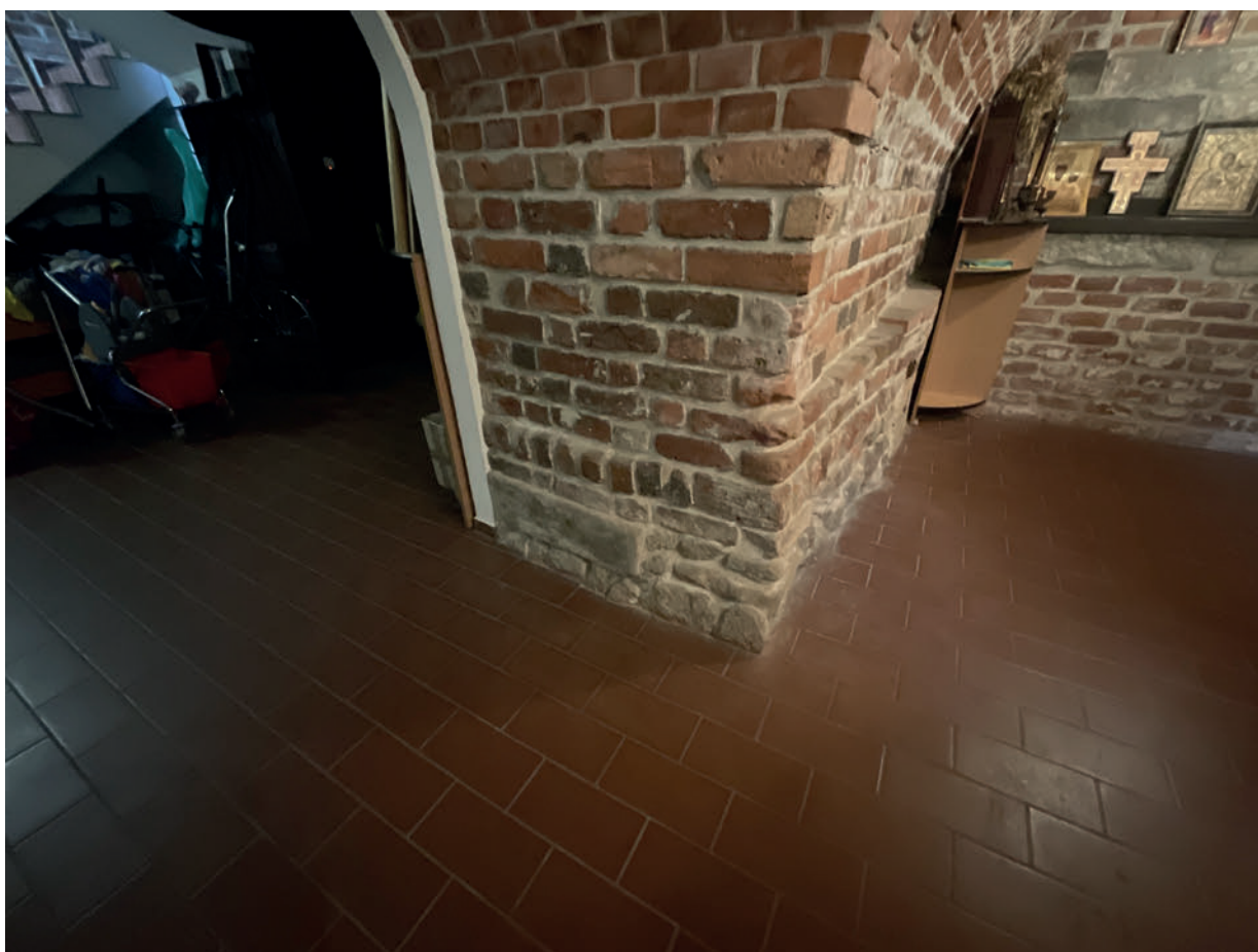
Il. 135. 2023 r. Krypty – ściana północna pomieszczenia pod przybudówką prezbiterium i dolna część przypory ściany południowej; fot. A.H.
