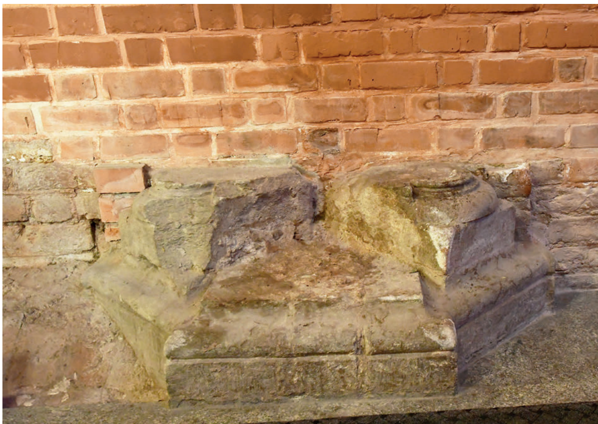
Il. 133. 2023 r. Zejście do krypty pod prezbiterium – zachowana baza pilastra; fot. A.H.
