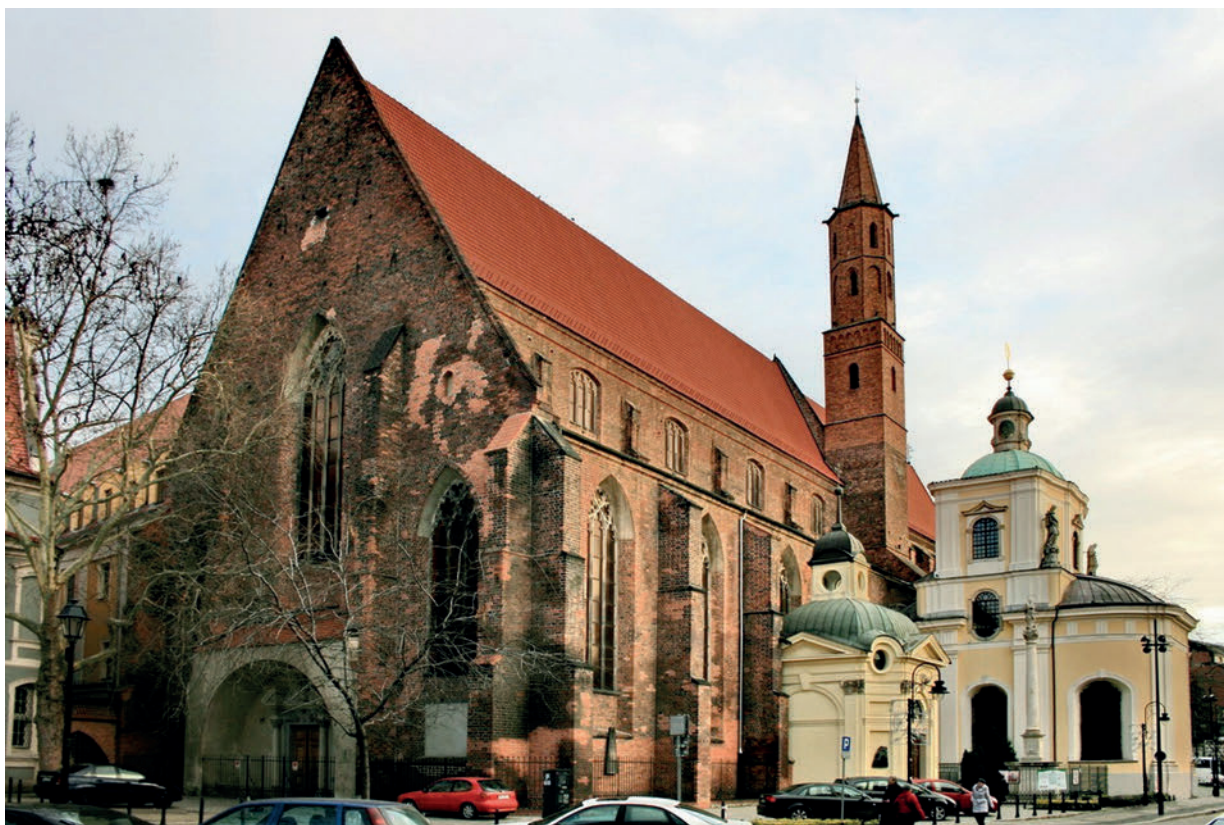
Il. 112. 2013 r. Elewacja zachodnia (przed remontem); fot. M. Brzeziński
