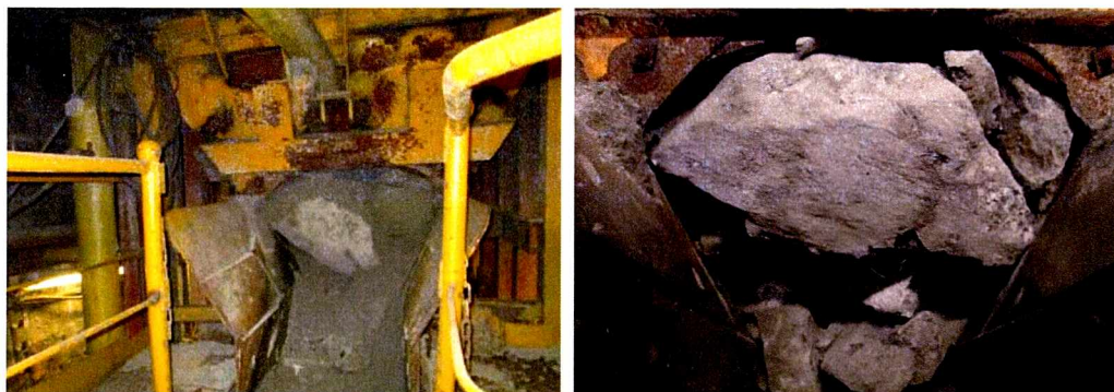
Rys. 1.19. Zablockowanie szuflady podającej zbiornika retencyjnego bryłą nadwymiarową
