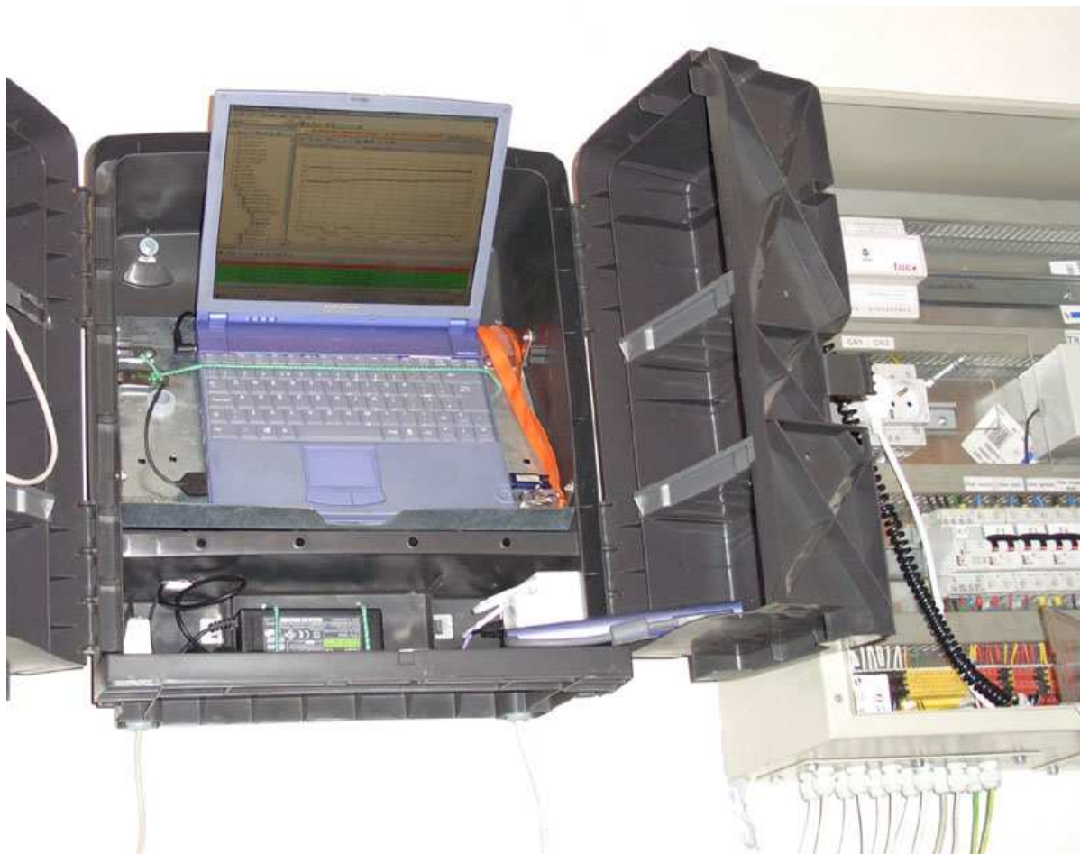
Rysunek 56: Komputer do zbierania danych oraz szafa sterownicza na węźle Gliniana 75
