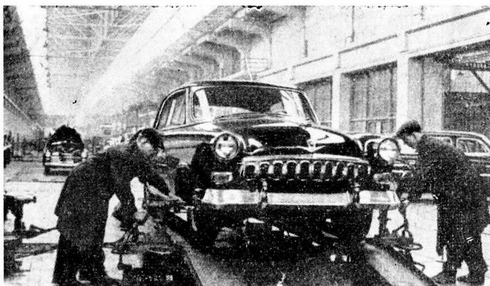
Rys. 2. W hali montażowej Fabryki Samochodów im. Mołotowa; samochód „Wolga” na stanowisku kontroli ustawienia kół
