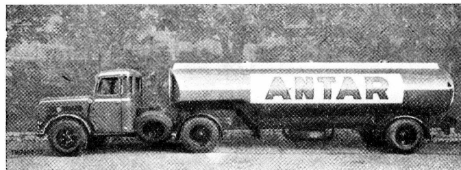
Rys. 2. Samonośna półprzyczepa — cysterna paliwa o pojemności 23500 l.
