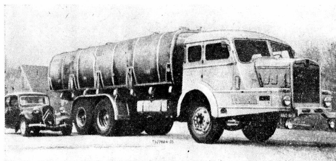
Rys. 4. Cysterna przechylna do transportu tlenku glinu.
