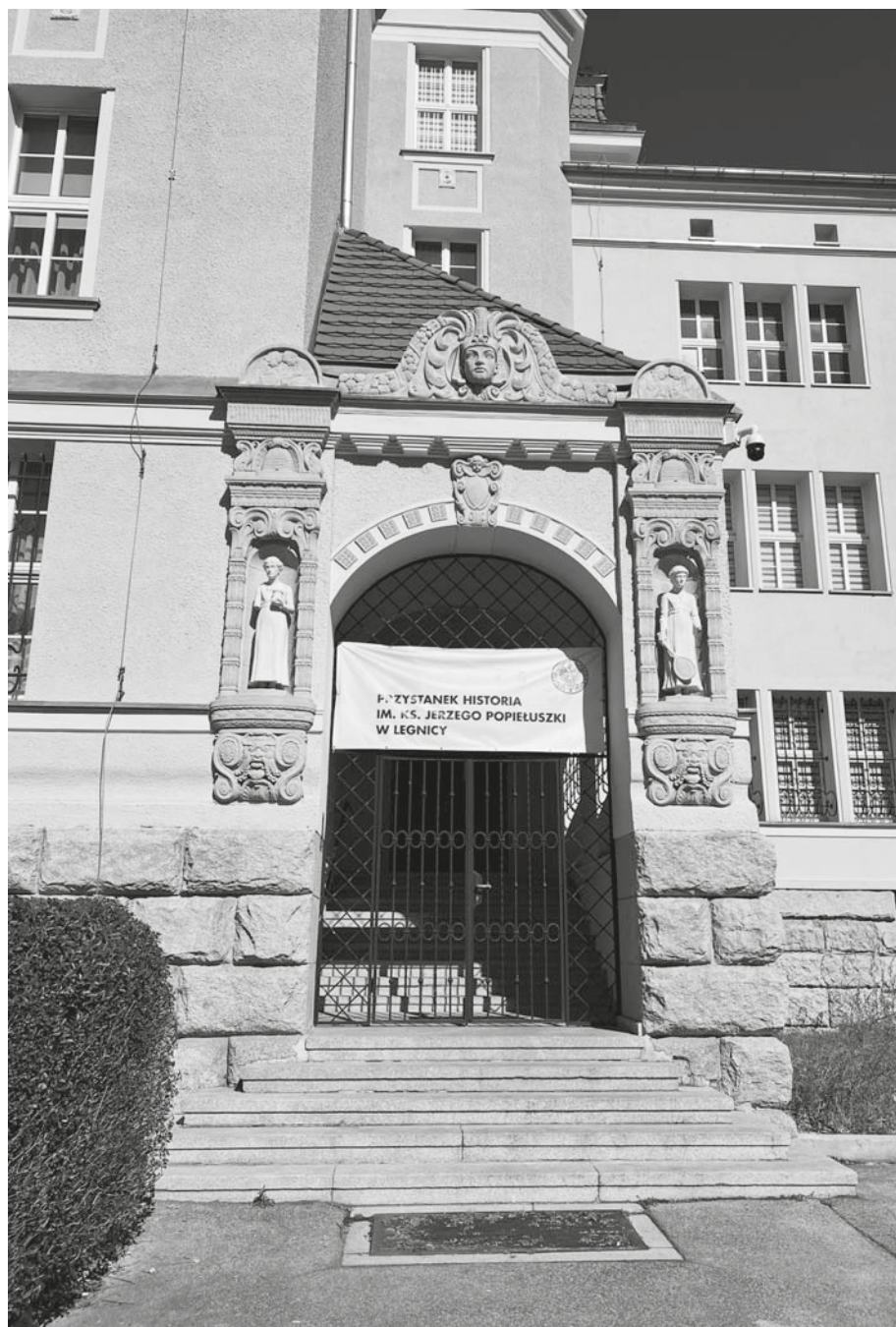
Wejście do Auguste Victoria Schule (obecnie gmach Kurii). Fot. M. Kot-Łazarz
