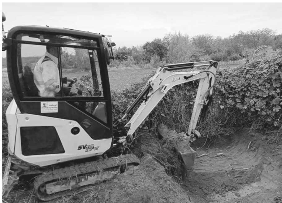
Prace ziemne wykonywane koparką w miejscu wskazanym przez właściciela posesji.
