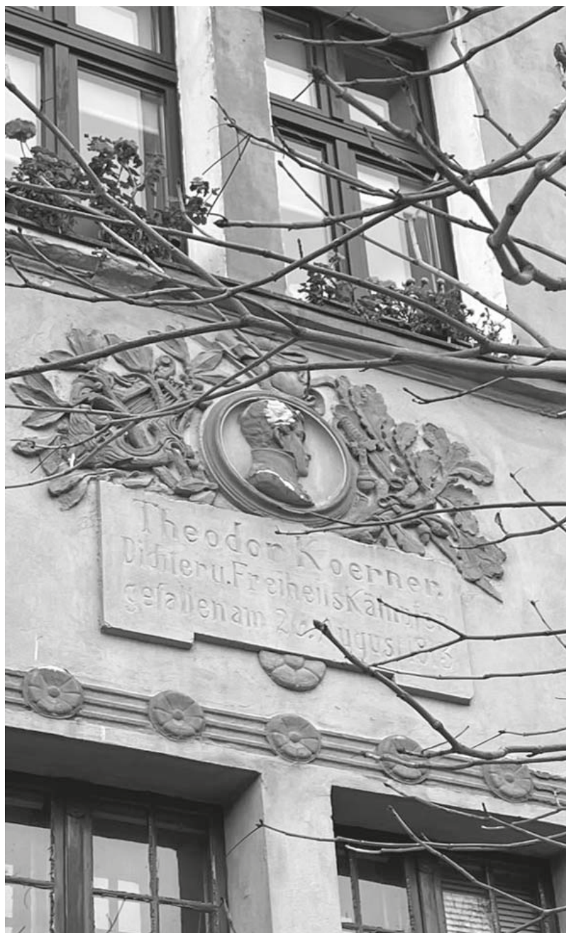
Medalion na fasadzie Koernerhaus (ul. S. Wyspiańskiego 11). Fot. M. Kot-Łazarz
