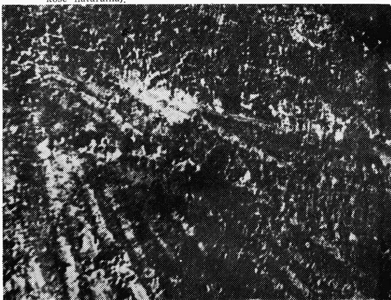
Fot. 6. Korozja lewej burty dochodząca do 2 mm głębokości po rocznej eksploatacji kutra od chwili budowy. Wżery powstały pomimo stosowania dotychczasowych metod konserwacji. Powierzchnia uwidoczniona na zdjęciu jest oczyszczona piaskowaniem i przygotowana pod metalizację (wielkość naturalna).
