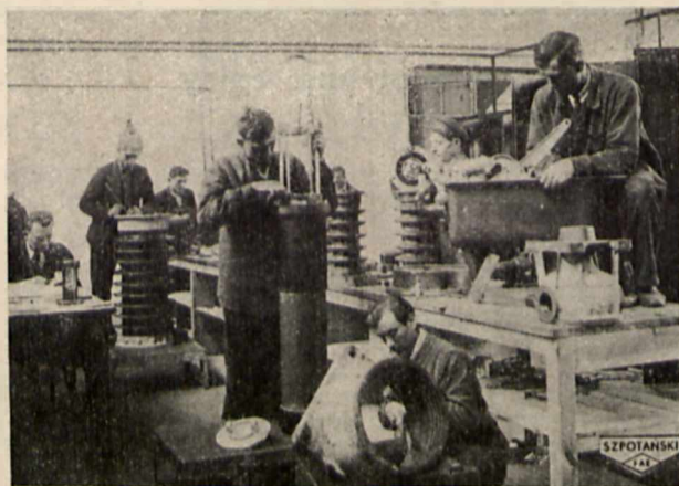
Fot. 4. Montaż części aktywnej wyłącznika 150 000 V
