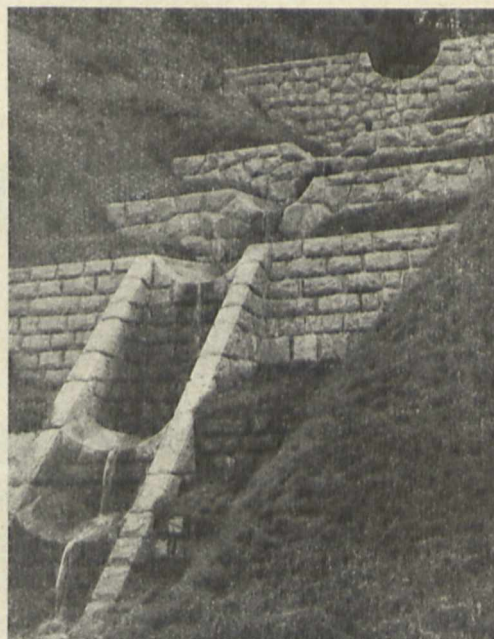
Rys. 4. Zabudowa jednego z potoków w obrębie zbiornika w Porábce.
