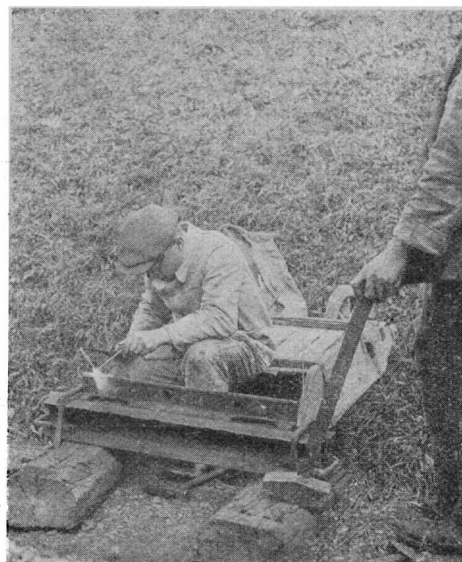
Rys. 8. Napawanie łubka
