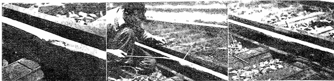
Rys. 10 Naprawa zapomocą palnika acetylenowego uszkodzonej główki szyny wskutek defektu w materiale.
