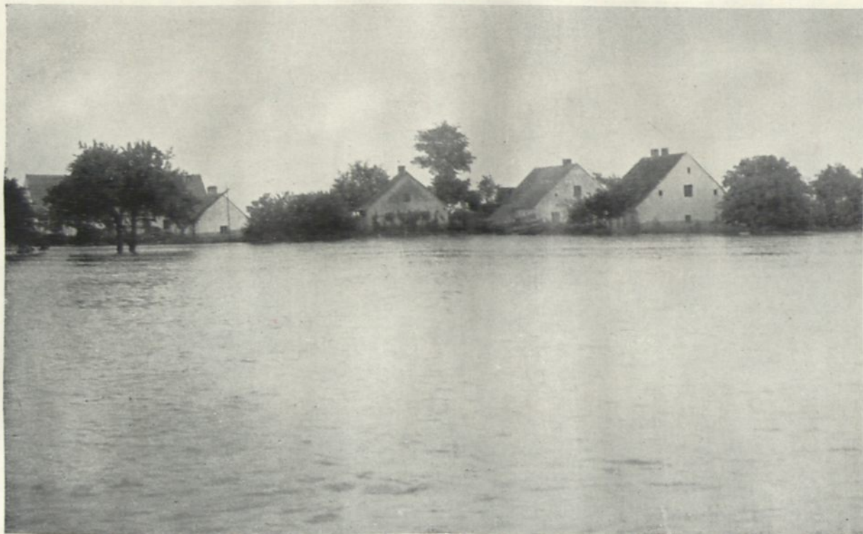
Hochwasser 1905. Kanjern von der Oberseite.
