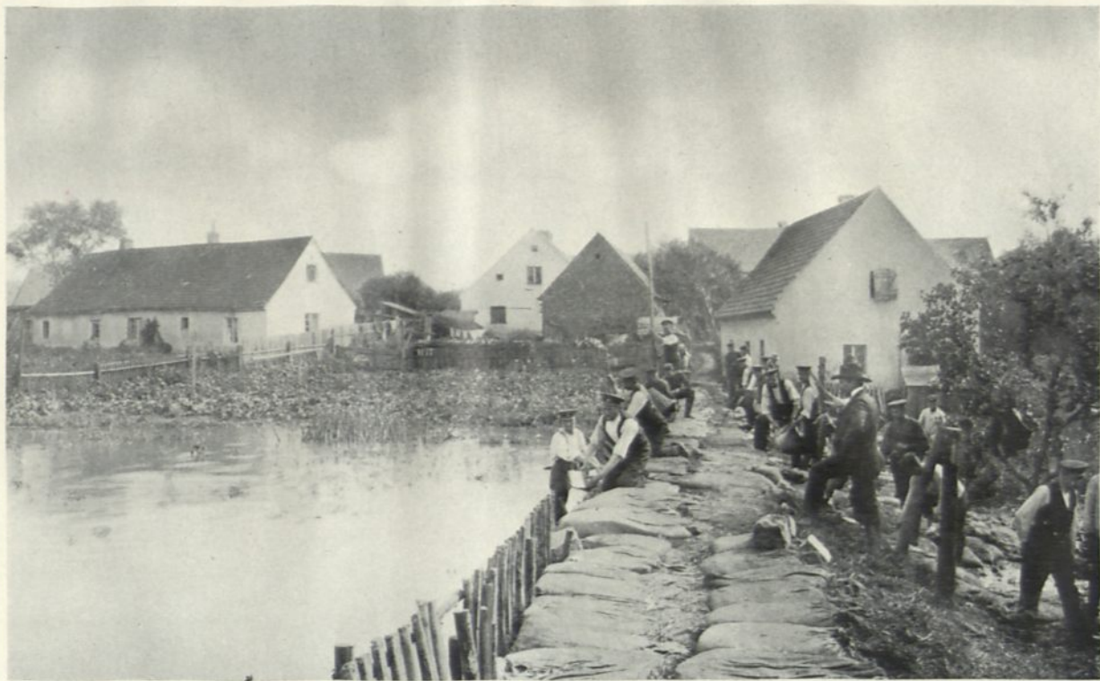
Hochwasser 1905. Künstlicher Damm bei Kanfern.
