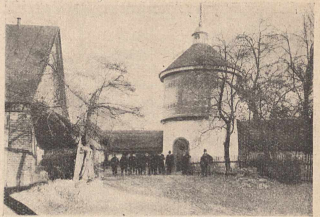
Rys. 4. Wieża wodna pojemności 30 m 3 wodociągu wielogminowego »Vrčky a okolí«.
