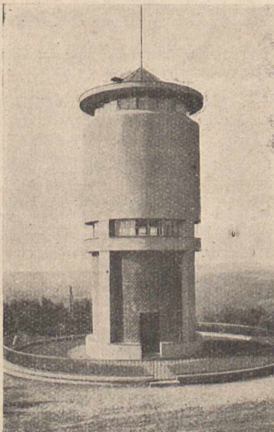
Rys. 3. Wieża wodna pojemności 50 m 3 wodociągu wielogminowego Bezdieického.
