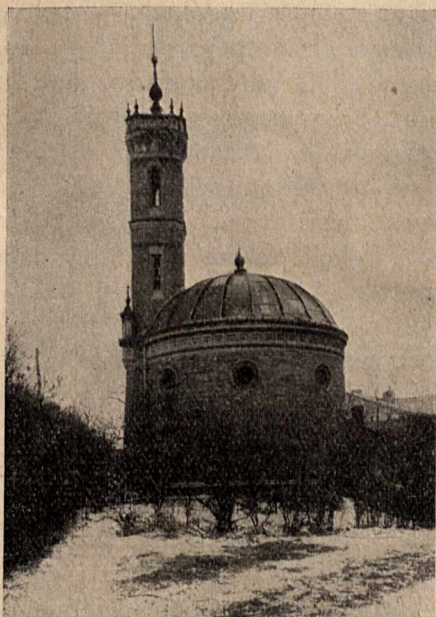
Rys. 3. Wieża ciśnienia i zbiornik wodociągów praskich (1869–1896).
