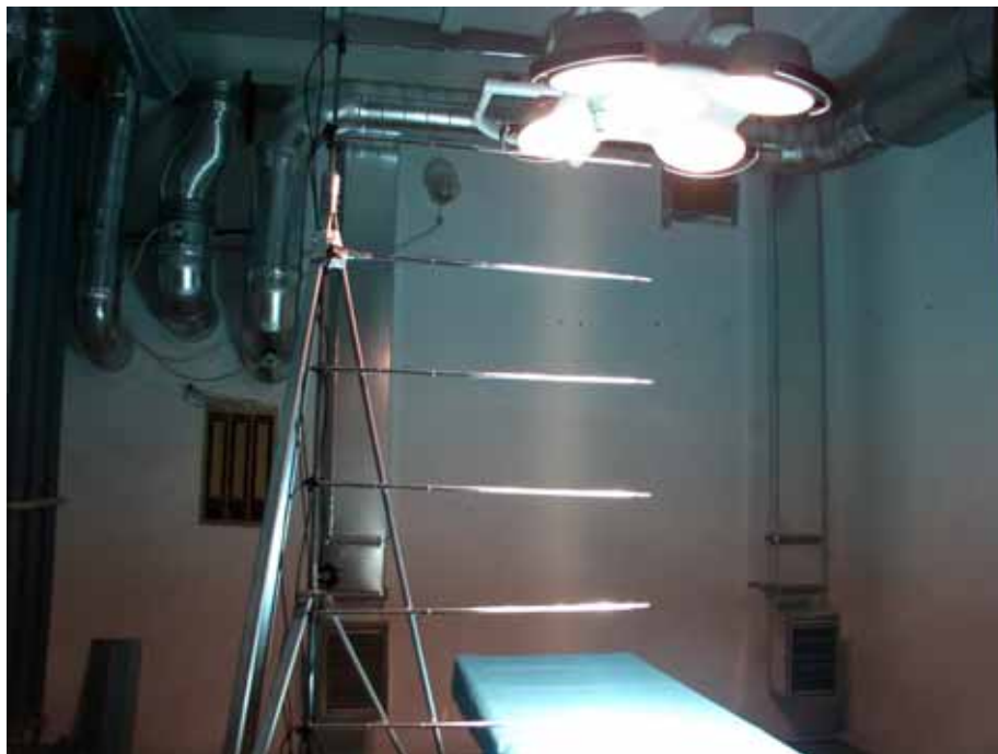
Rys. 2.55 Sondy pomiarowe, lampa bezcieniowa oraz instalacja powietrzna
