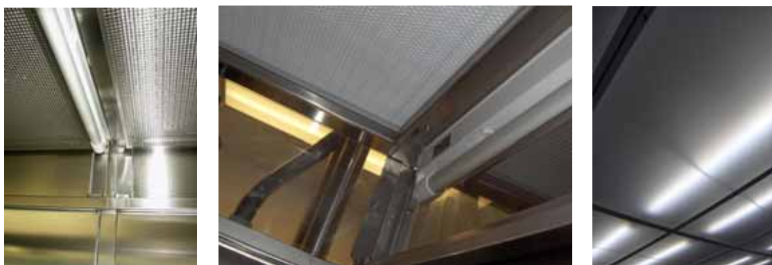
Rys.1.42 Przykładowe usytuowanie opraw oświetleniowych firmy TRILUX w skrzyniach nawiewnych stropów laminarnych typu LAM firmy CLIMA TECH, przeznaczonych do zastosowania z rozdzielaczami tkaninowymi [135]
