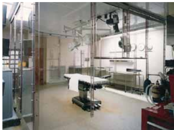
Rys.1.50 Zdjęcie przedstawiające współczesny 'greenhouse' - kabinę operacyjną (Enclosed Surgical Ventilation System) typ 'Lami-Gard™ System' amerykańskiej firmy Precision AirProducts Co. [137]
