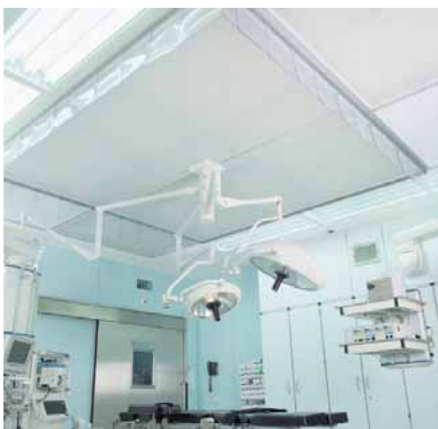
Rys.1.58 Widok stropu z przepływem laminarnym, typ ULA.3 z kurtynami ograniczającymi z PCV, z bezpośrednią recyrkulacją z pomieszczenia, firmy WEISS [138]
