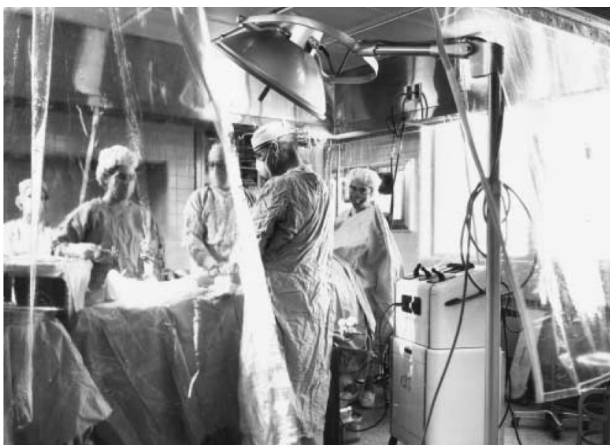
Rys.1.45 Pierwsza w historii kabina operacyjna z zastosowaniem laminarnego przepływu powietrza [71]
