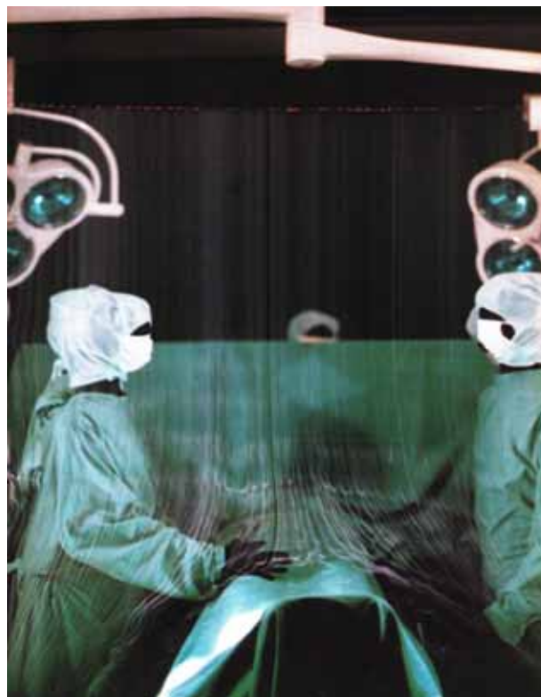
Rys.1.36 Laminarny idealny przepływ tłokowy powietrza wytworzony przez nawiewnik typu OP firmy NICKEL [56]
