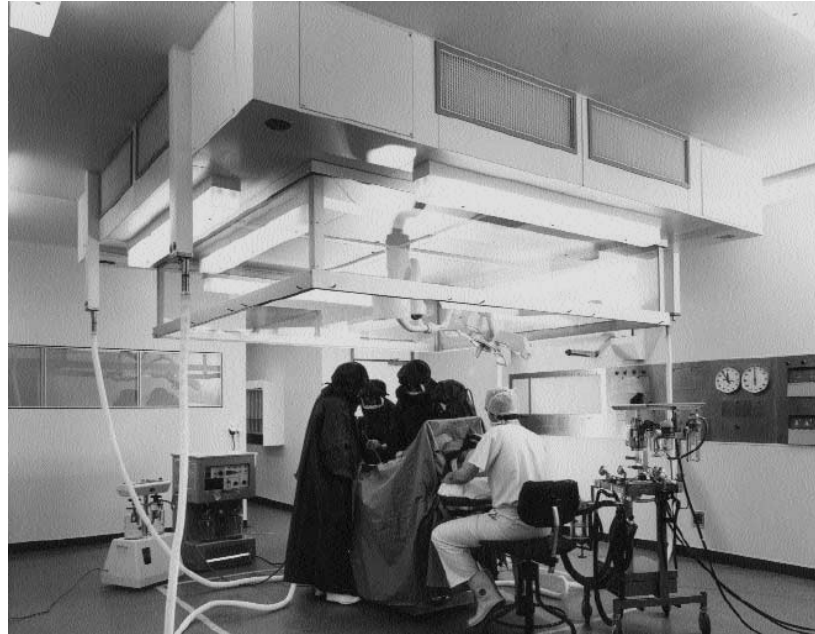
Rys.1.46 Nawiewnik laminarny 'Mark I' w sali szpitala Wrightington , Howarth Air Engineering Ltd. [69]
