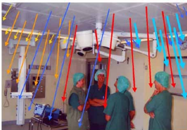
Rys.1.11b Modułowy strop laminarny w sali operacyjnej, typ AET-V4-UCA firmy Howorth AirTech [40a]
