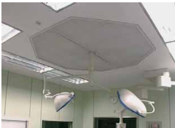
Rys.1.56 Ośmiokątny strop laminarny typ ULA bez kurtyn ograniczających, firmy ADMECO AG [139]
