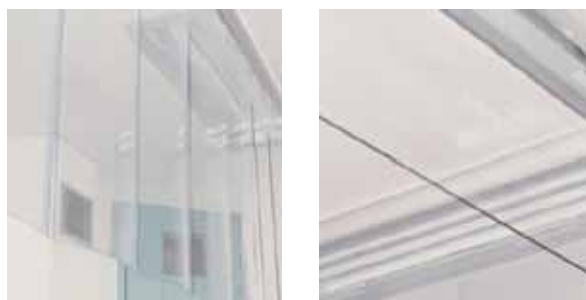
Rys.1.52 Kurtyna ochronna w wykonaniu z PCV (po lewej stronie) oraz ze szkła wzmocnianego lub pleksiglasu (po prawej stronie) [138]
