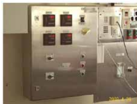
Rys.1.11c Panel sterujący modułowego systemu nawiewnego, firmy Howorth AirTech [40a]
