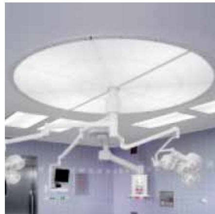
Rys.1.57 Okrągły strop laminarny typ OPTIMA CG bez kurtyn ograniczających, z wewnętrznym oświetleniem, firmy McLeod RUSSEL Filter GmbH [140]
