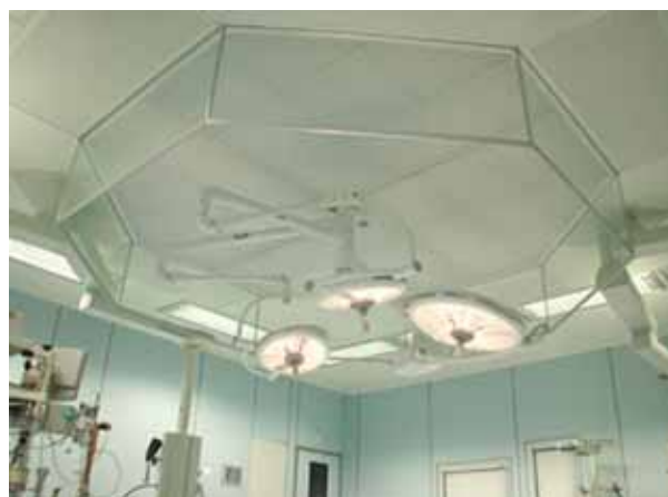
Rys.1.55 Ośmiokątny strop laminarny typ ULA z bocznymi kurtynami ograniczającym, firmy ADMECO AG [139]
