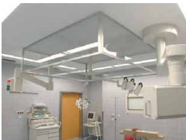
Rys.1.54 Prostokątny strop laminarny typ FFA z bocznymi kurtynami ograniczającym, firmy ADMECO AG [139]
