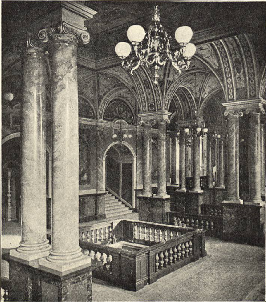
Foyervestibül im Neuen Hoftheater zu Dresden.
