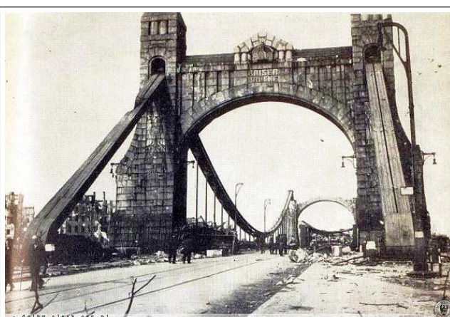
Ryc. 89. Zniszczony most Grunwaldzki (niem. Kaiserbrücke ), 1945 rok.
