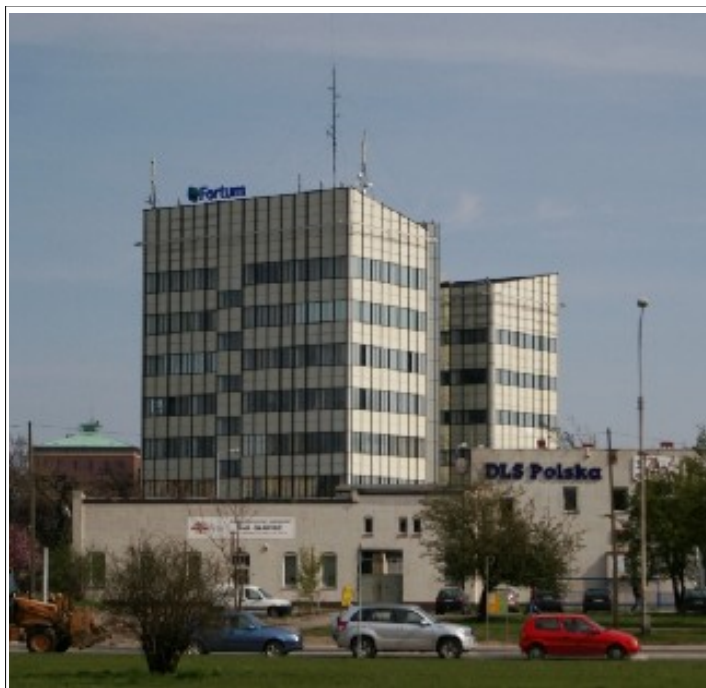
Ryc. 140. Biurowiec Fortum przy ul. Walońskiej nr 3-5, zakończenie budowy na początku XXI wieku, (autor: J. Bizunowicz).
