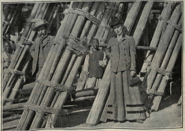
Stangenbündel zu chinesischen Baugerüsten.
