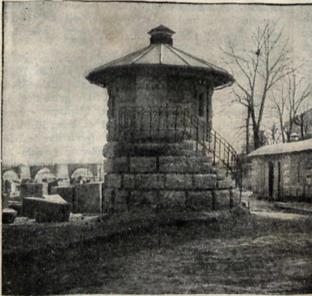
Das königliche Fernheiz- und Electricitätswerk in Dresden: Pumpenhaus an der Elbe.
