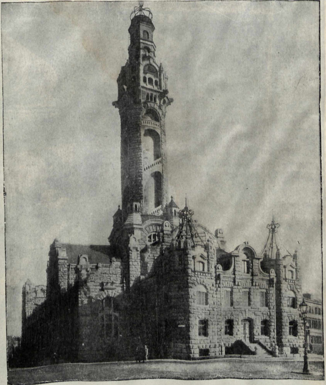
Das königliche Fernheiz- und Electricitätswerk in Dresden: Krafthaus.
