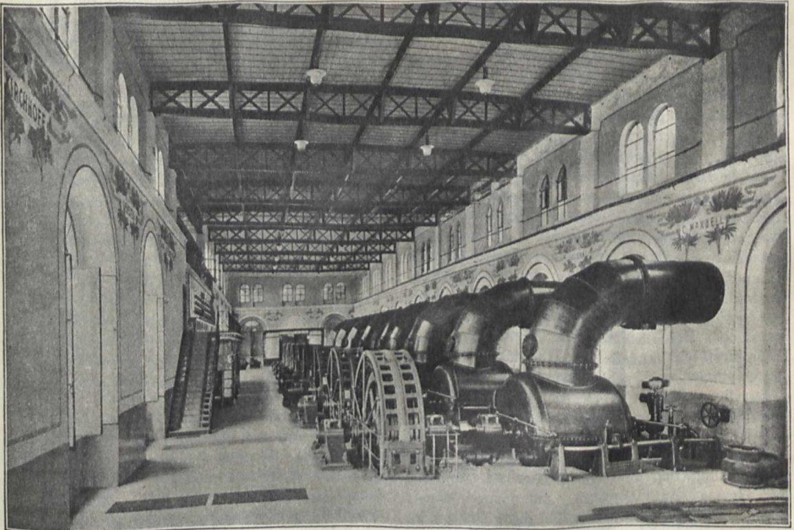
Das Elektrizitätswerk in Vizzola: Innenansicht des Maschinenraumes.
