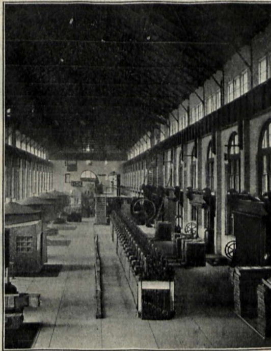
Die neue Kraftstation der Niagara Power Company: Turbinenhaus mit der Schaltanlage.
