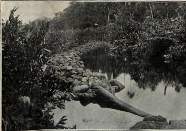
Weg aus verbrannten Basaltblöcken durch den Mangrovesumpf bei Fluth.
