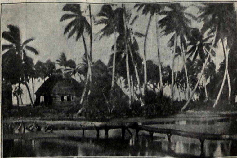
Brücke aus Cocosstämmen bei Satulepai (Savaii).
