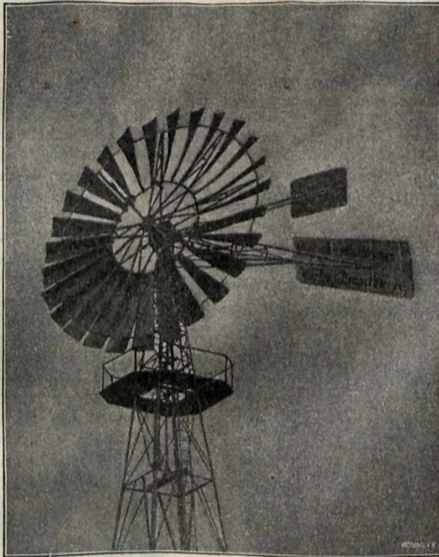
Stahlwindturbine „Hercules“, bei starkem Wind halb ausgerückt arbeitend.
