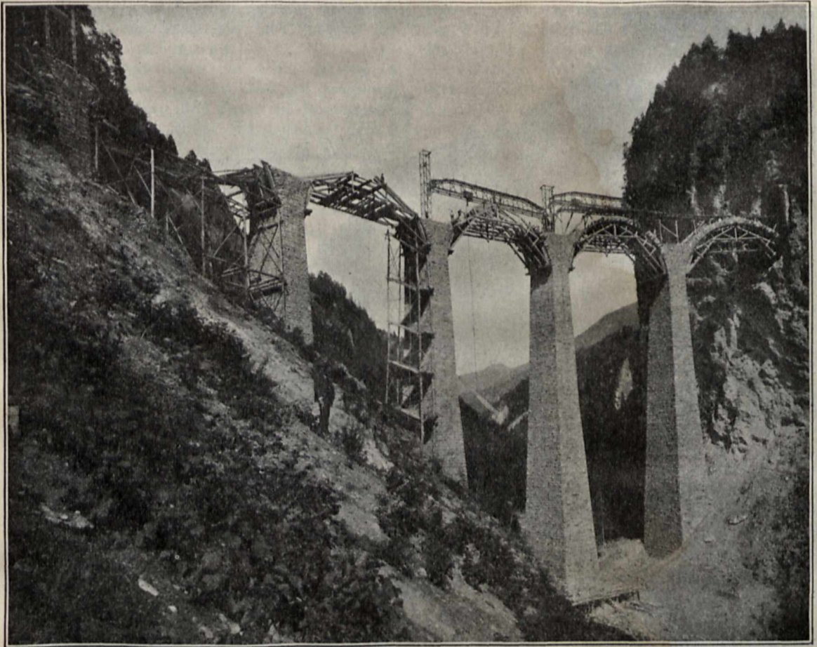
Die Albula-Bahn: Der Landwasser-Viaduct im Bau (1902).
