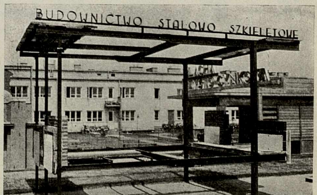
Model konstrukcji stalowo-szkieletowej, wypełnienie ścian, stropy i krycie dachów.
