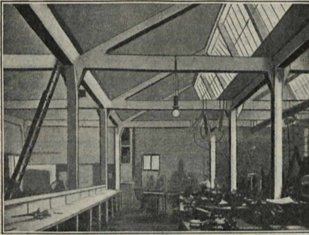
Fabrikraum mit Eisenbeton-Dach.
