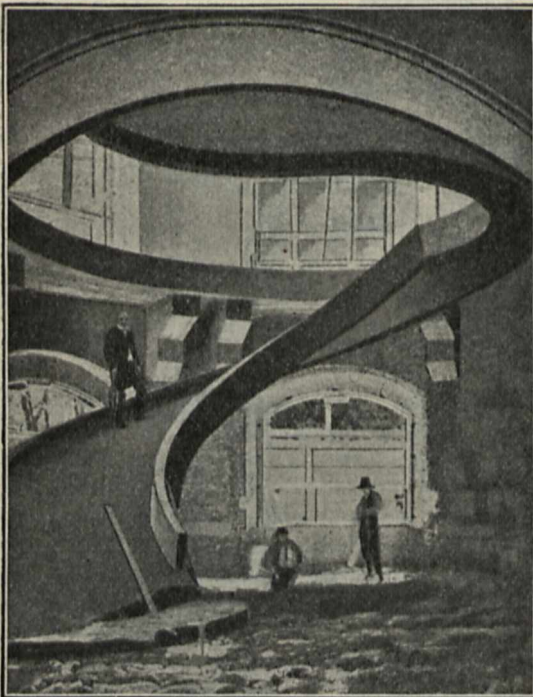
Wendeltreppe in Eisenbeton.
