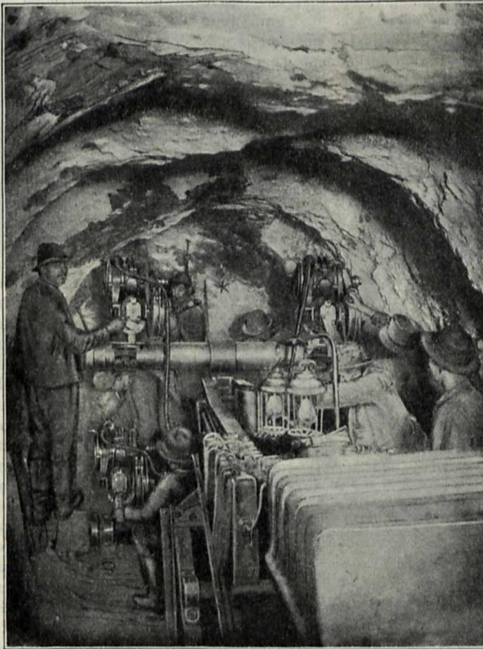
Bohrung vor Ort mit vier Kurbelstoss-Bohrmaschinen im Wocheiner Tunnel.
