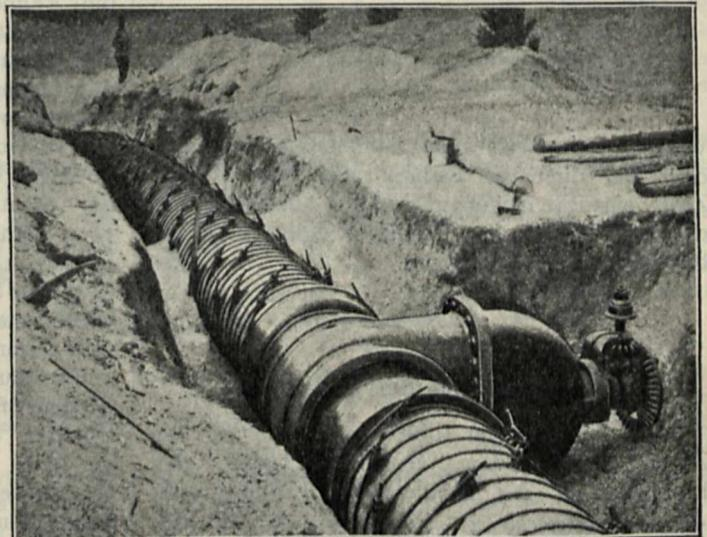
Holzrohrleitung mit eingebautem Zwischenstück aus Stahlguss nebst Schieber.
