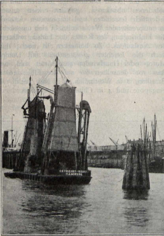
Pneumatischer Getreideheber der Hamburg-Amerika-Linie.
