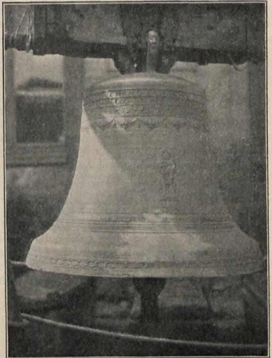
Der durch Ausbohren und Ausmeisseln erweiterte Riss.
