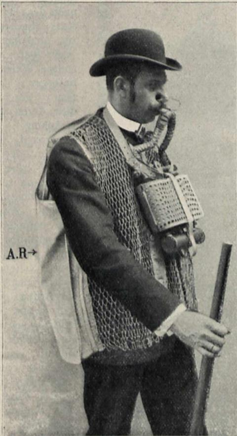
Athmung mit dem „Arbeits“-Apparat (Pneumatogen Type II). A R Athmungsrock.
