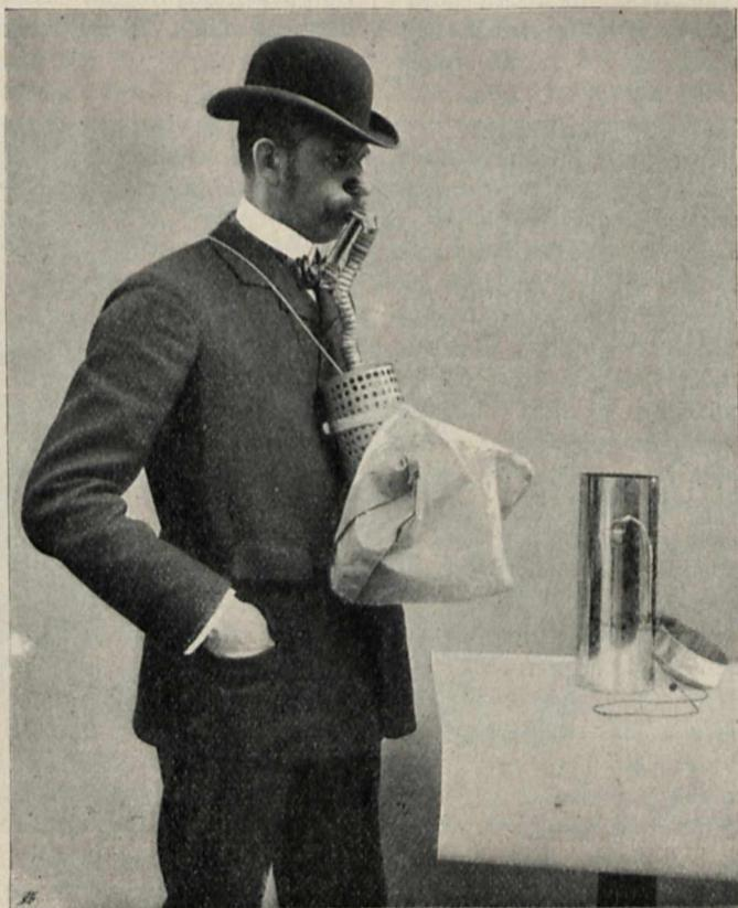
Athmung mit dem Selbstrettungsapparat („Pneumatogen“ Type I).
