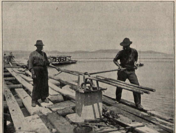
Vorbereitung der Pfahlköpfe zum Anschluss der Längsträger.
