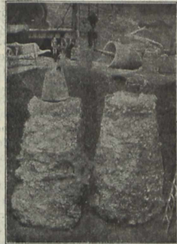
Ausgegrabene Betonpfeiler, System Dulac. Links flacher, rechts gerundeter Fallstössel.
