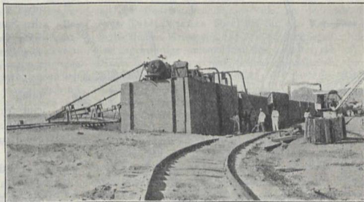
Füllen der Formkästen mit Betonmasse.
