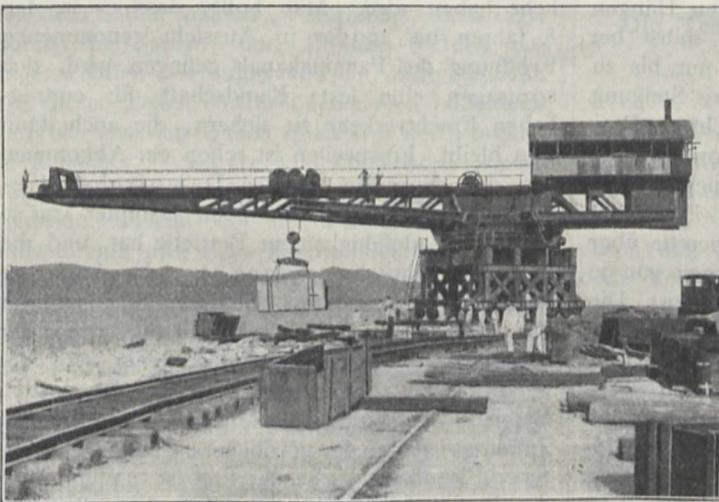
Fahrbarer Riesenkran zum Auslegen der Steinblöcke beim Bau der Hafendämme.
