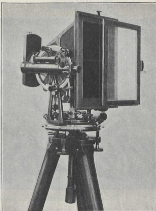
Photogrammetrischer Apparat des Ingenieurs Paganini.
