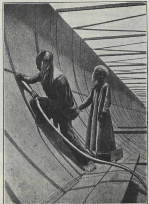
Verstemmen der Nietnähte mittelst Luftdruckhammer.
