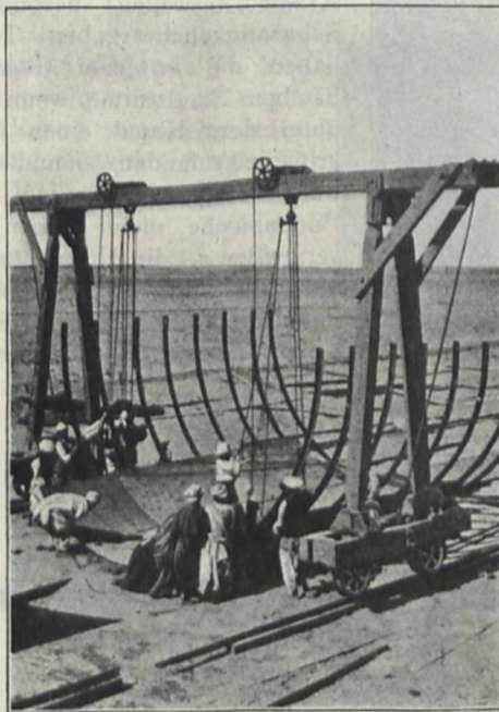
Montagekran bei der Bodenverlegung.
