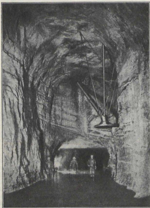
Unteres Ende der Ausblaseleitung in der unterirdischen Kammer.
