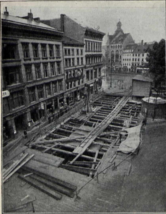
Abdeckung der Tunnelbaugrube mit Bohlen während des Baues.
