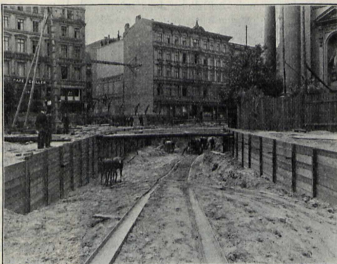
Ausschachtung der Tunnelbaugrube am Deutschen Dom.
