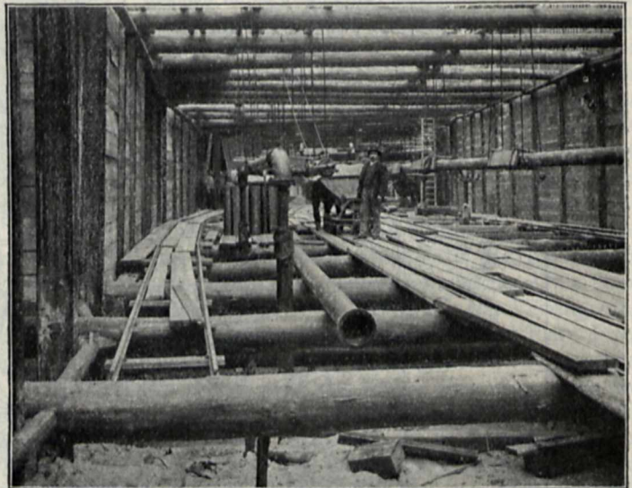
Blick in eine oben offene Baugrube in der Wallstrasse.
