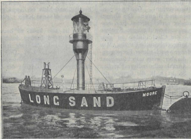
Unbemanntes Gasfeuerschiff mit automatischem Glockenwerk (Julius Pintsch A.-G., Berlin).
