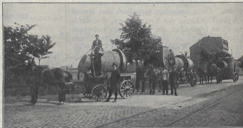
Büttnerscher Allestrockner, fahrbar (grössere Anlage, in mehrere Teile zerlegt, auf dem Transport).
