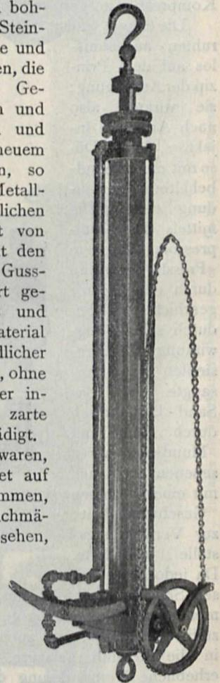
Presslufthebezeug der Internationalen Pressluft- und Elektrizitäts-Gesellschaft m. b. H.
