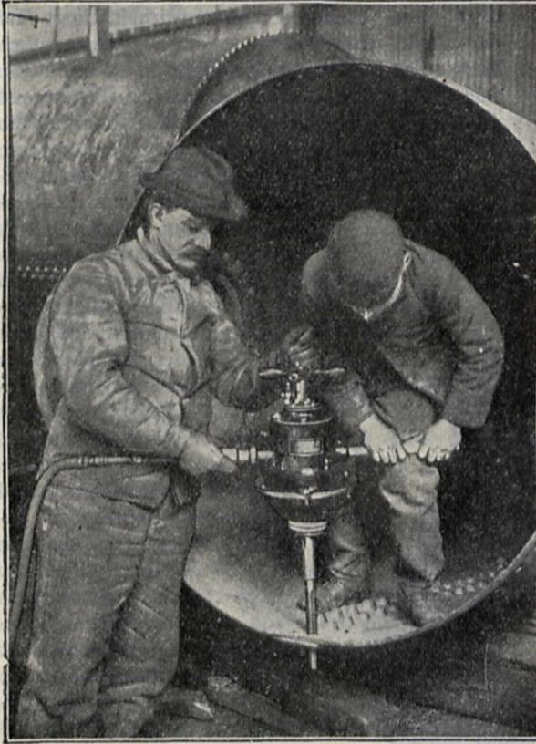
Pressluftbohrmaschine der Internationalen Pressluft- und Elektrizitäts-Gesellschaft m. b. H.
