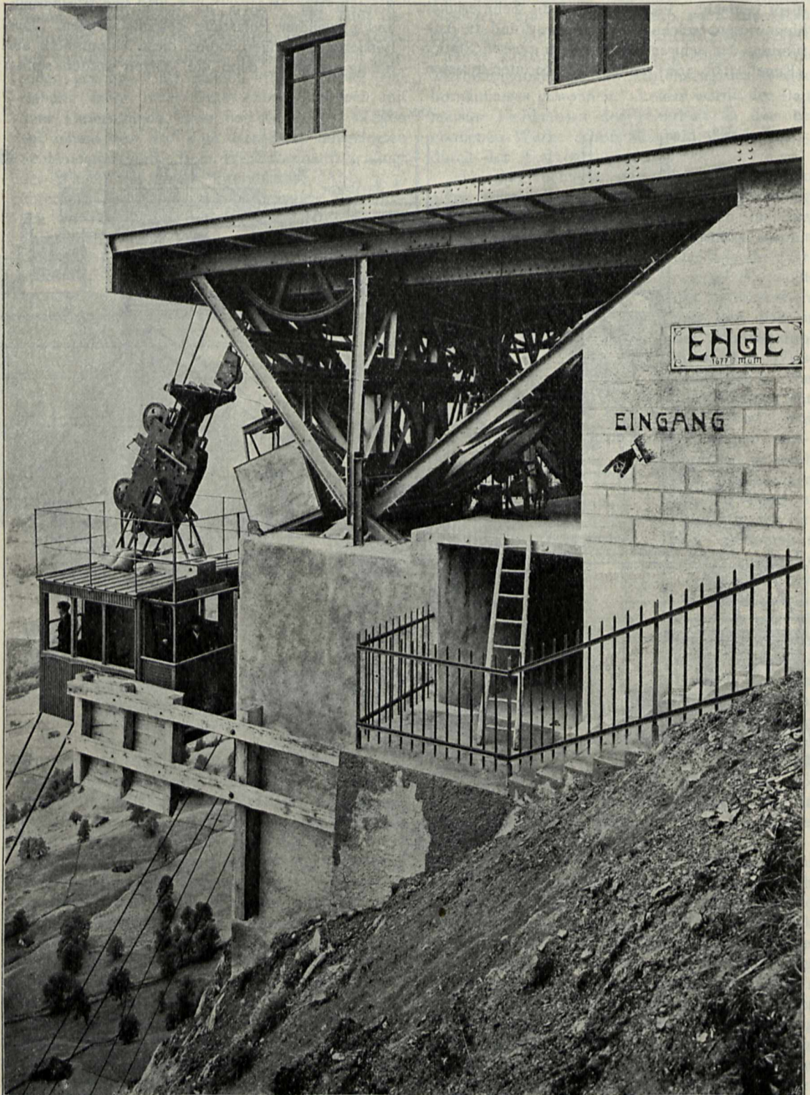
Traggerüst der (oberen) Station „Enge“ mit Bremswagen und Kabine.
